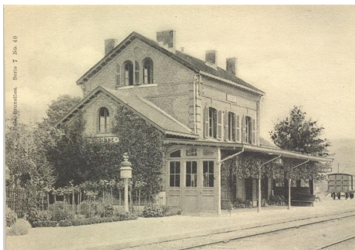
Fig. 3 : Bâtiment des voyageurs de Godinne à l'époque de son exploitation par la Compagnie du chemin de fer du Nord. Collection PFT.
