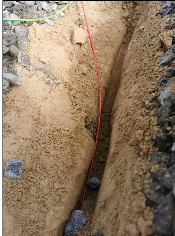
Installation de la fibre optique
