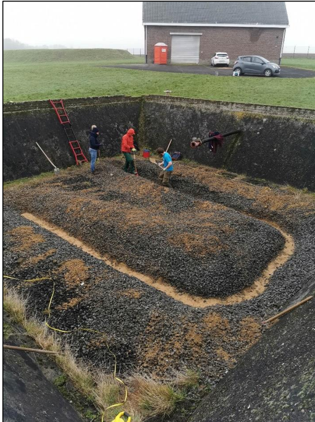
Préparation des tranchées
