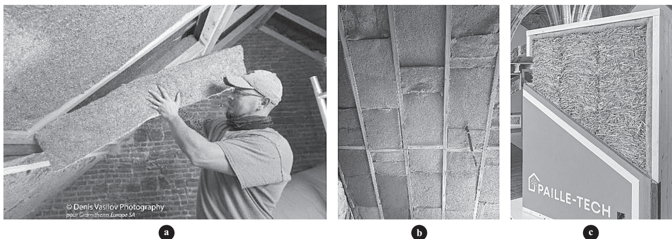
▲ Photo 9. Isolants biosourcés sous forme de matelas souples, mis en œuvre entre structures : (a) fibres d'herbe, (b) fibres de bois et (c) paille en ballot mise en œuvre dans un caisson bois (source : Gramitherm (a), D. Stiernon (b), S. Trachte (c)).
