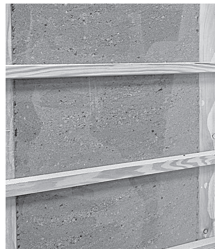
▲ Photo 8. Isolants biosourcés en vrac, mis en œuvre entre ossatures : fibres de bois issues de la valorisation de déchets de MDF recyclé, insufflées en caisson (source : Lenoo).
