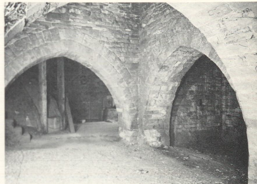
Fig. 6. Bas de la tour nord vu du nord. On aperçoit la demi-coupole qui couvrait le buffet d'orgue et le bas de l'escalier accédant aux combles de la nef (cliché A.C.L.).
