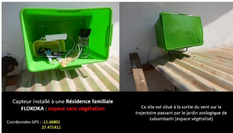
Figure A5-5 : installation capteur à sortie du vent passant par l'espace vert du jardin zoologique de Lubumbashi.
