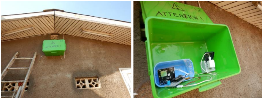
Figure 5-6 : Installation des capteurs sur les murs.
