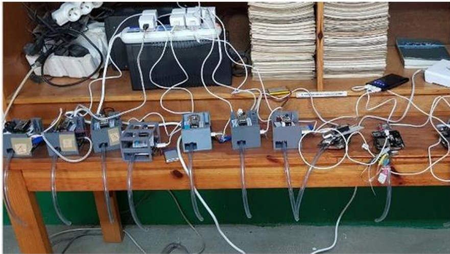
Figure 5-5 : Dispositif de colocalisation des micro-capteurs de PM 2,5 et PM 10 pour le calibrage : les capteurs sont installés côte à côte et exposés aux mêmes conditions afin de comparer leurs mesures et d'ajuster les capteurs secondaires à partir du capteur de référence.
