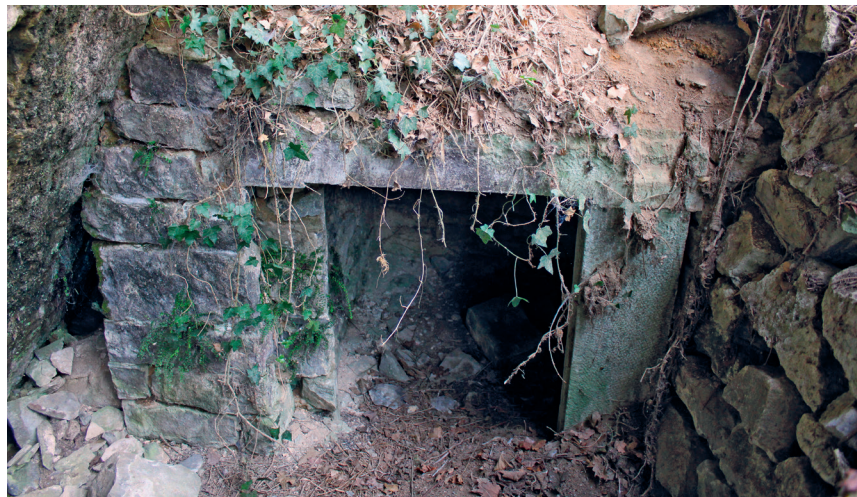
Fig. 34.- Idem, ancien abri à poudre de la carrière.
