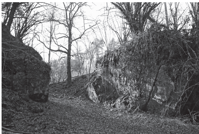
Fig. 21.- Comblain-au-Pont, la carrière Julémont, entrée de la carrière percée dans le roc, correspondant au pied de la rampe inclinée menant au chantier (non visible). © Antoine Baudry, 2023.
