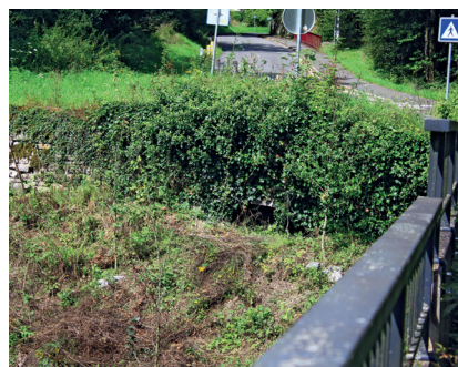
Fig. 24.- Comblain-au-Pont, la carrière Julémont, ce même tunnel, aujourd'hui. On distingue encore la clé d'arc. © Antoine Baudry, 2023.
