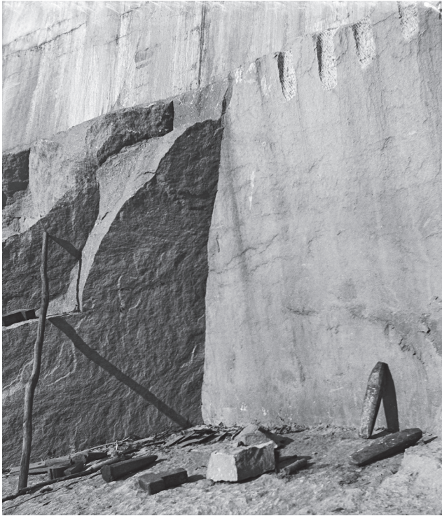
Fig. 37.- Sprimont, carrière de Correux, spigots (en bas) et vestiges de leurs trous (en haut), vestiges de l'étape visant à détacher des blocs de la roche, début du XX e siècle. © Province de Liège - Musée de la Vie Wallonne, MVW 1020015-6.
