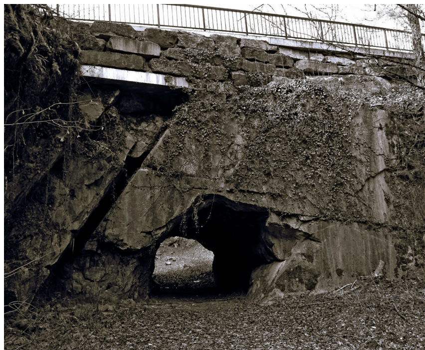
Fig. 25.- Idem, tunnel creusé à même le roc opérant une jonction entre les deux trous d'extraction, sous la voirie communale. © Antoine Baudry, 2023.
