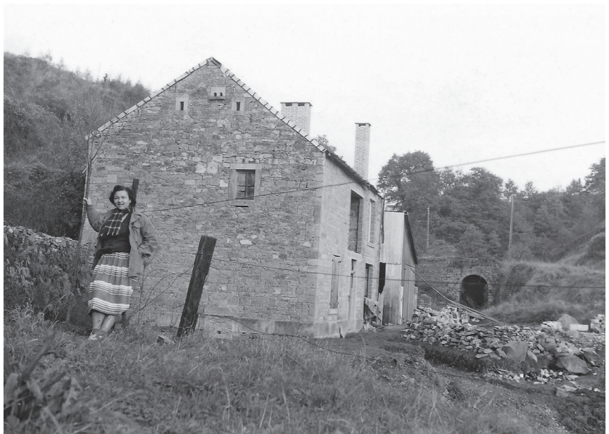
Fig. 28.- Idem, la grange Julémont et l'ancien tunnel reliant la carrière au chantier. Archives privées de Denise Dewitt.
