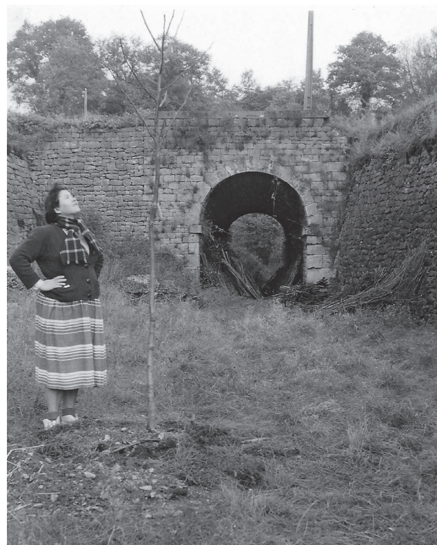
Fig. 22.- Idem, le tunnel opérant une connexion entre la carrière et le chantier. Archives privées de Denise Dewitt.
