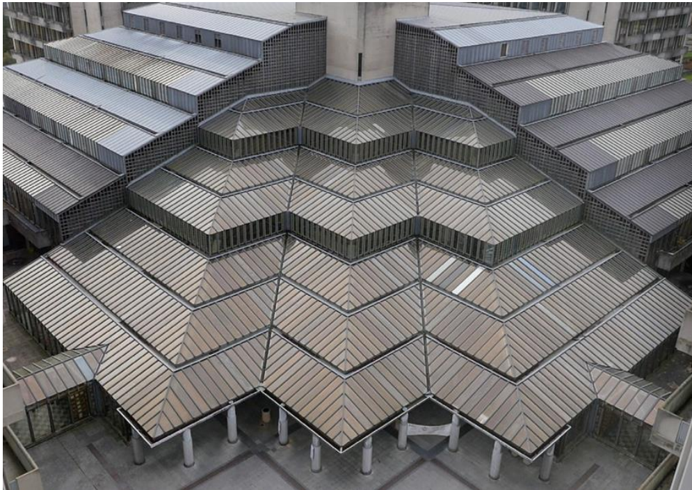
Figure 7 : Vue extérieure de la verrière du bâtiment principal du CHU de Liège[14].
