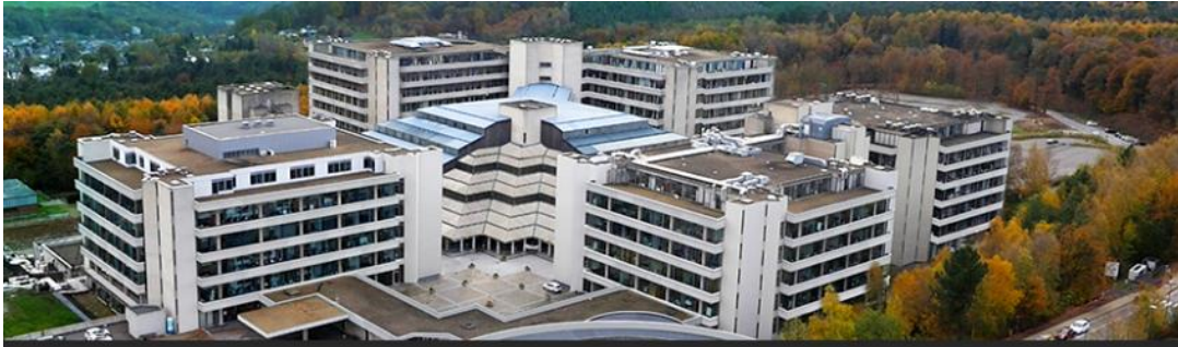
Figure 9 : Vue aérienne du CHU de Liège[16].
