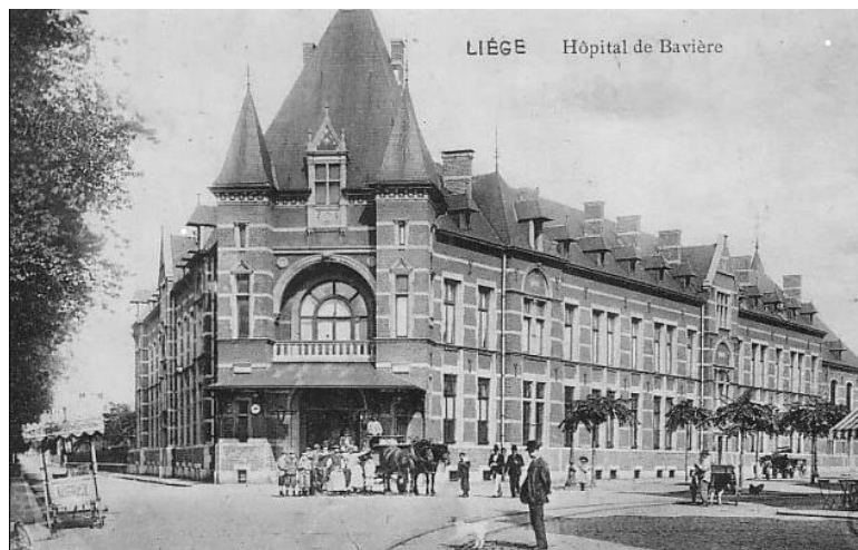
Figure 6 : Façade de l'Hôpital de Bavière[10].
