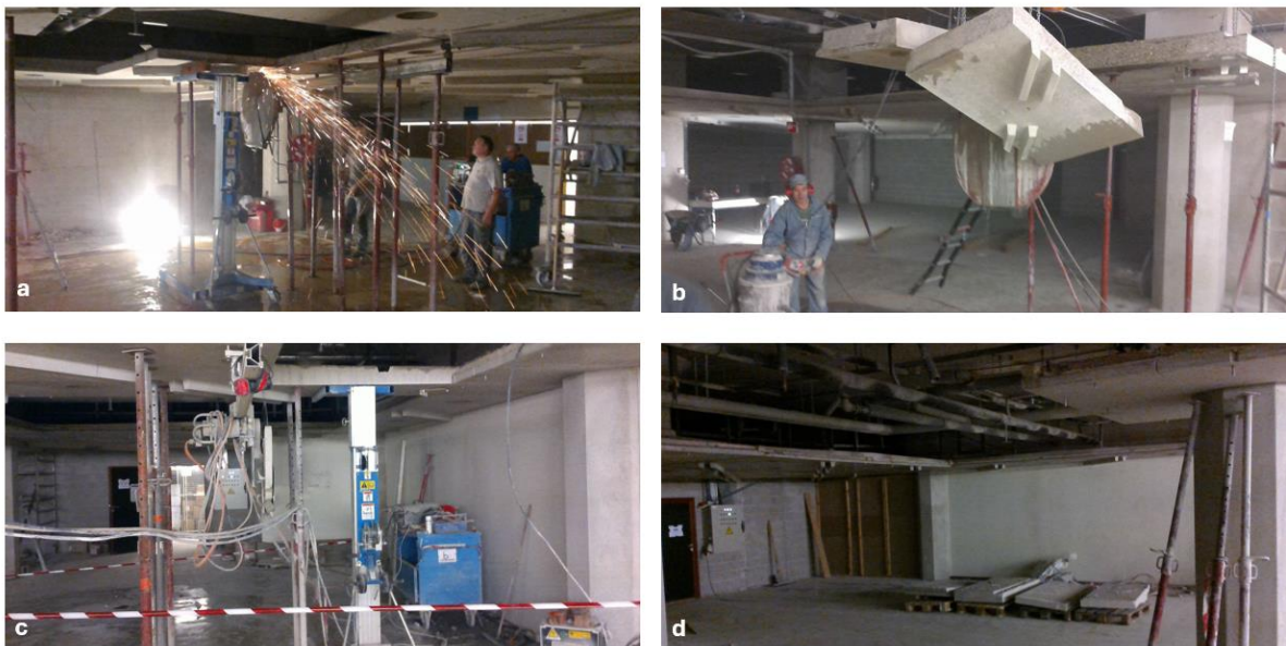
Figure 95 : Destruction du faux plafond du CHU de Liège, niveau -4, en vue de la construction de la zone de production. Les dalles sont sciées sous eau (a) puis descendues (b). Le faux-plafond résiduel est solidement étançonné (c) et les dalles sont extraites de la zone (d).
