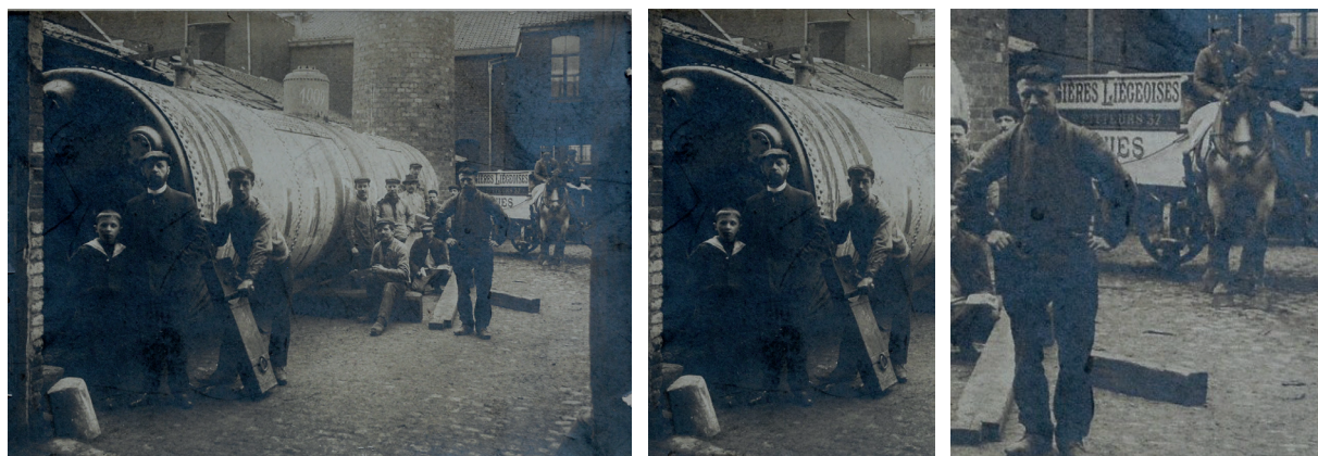
Fig 23. a) La nouvelle chaudière placée dans la cour des « Glacières Liégeoises Réunies » (Archives familiales de Robert Koelman)
