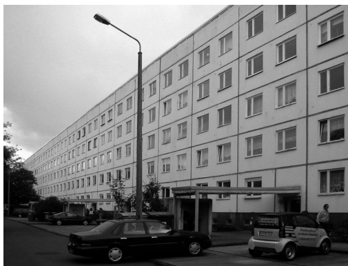
Abb. 6: Haus 08 in Halle an der Saale vor der Sanierung von Stefan Forster GmbH. Nachweis: Valentin, Jean Luc: Haus 08, Sanierung in Halle an der Saale, Stefan Forster GmbH, 2010
