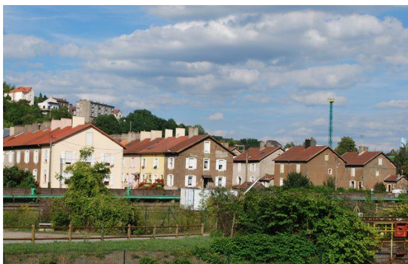
L'IRIS de type I. Faubourg St Maurice à Hayange : une cité ouvrière composée de maisons répétitives avec un petit enclos construites en 1914. (Source : www.ressources-edu.fr )
