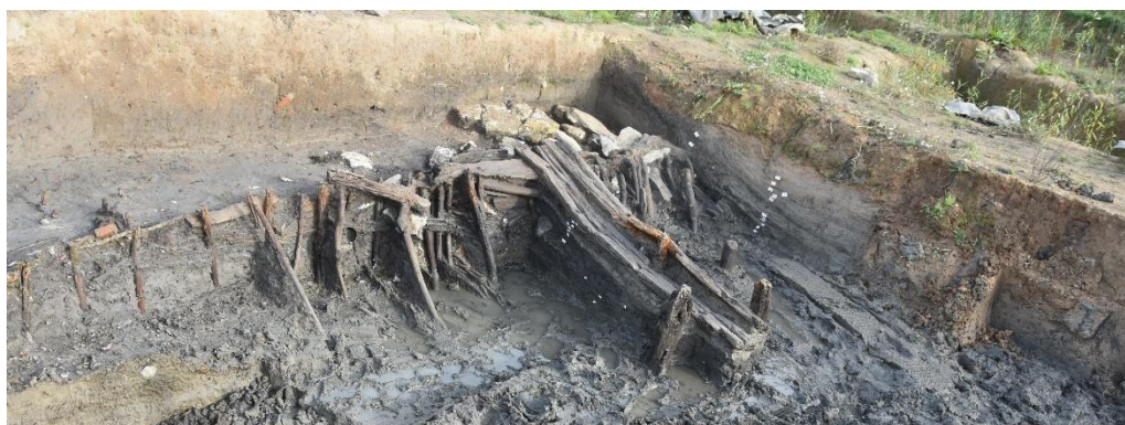
fig. 4 – berge interne des douves du XV e siècle et le ponton (© AWaP)
