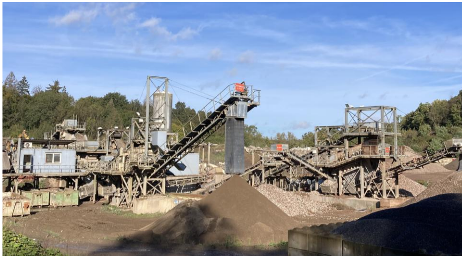
Centre de recyclage de Namur (Recynam)
