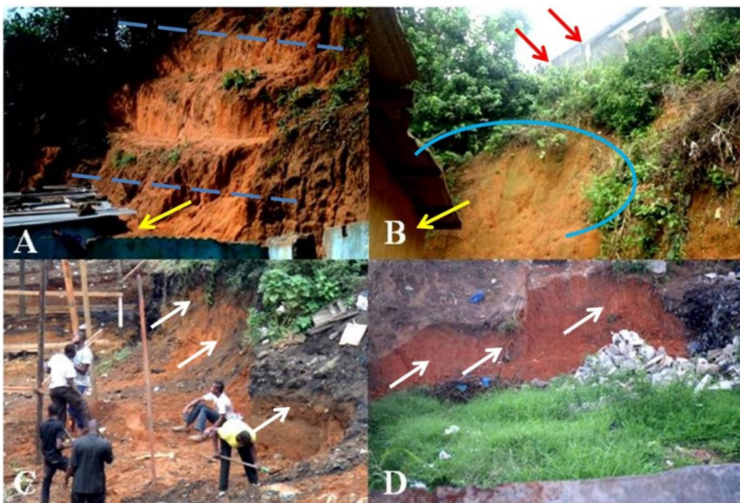
Figure 8: Interventions humaines observées sur l'aire étudiée. A : vue vers EW du terrassement d'un versant dans le quartier de Mossikro. Les lignes bleues en pointillé représentent des terrasses réalisées. La flèche jaune correspond à un bâti au pied d'un versant. B : vue vers NS d'un versant dénudé dans le quartier de Mossikro. Les flèches rouges indiquent un bloc bâti au sommet du talus. La ligne bleue pleine représente la limite supérieure de ce talus. La flèche jaune correspond à une construction au pied du versant. C et D : vues respectives vers EW de l'entaille des pieds de versant dans les quartiers de Boribana et Nematoulaye.
