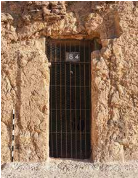
Fig. 5 De nordlige og sydlige dørstolper ved indgangen til TT 84. Foto M.K., 2016.
