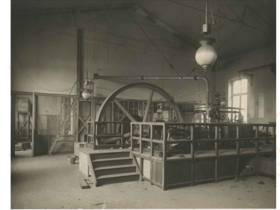
MORIN Lambert, Machine à vapeur du laboratoire de mécanique appliquée, faculté technique de l'Université de Liège, vers 1900. (Musée Wittert - Collections artistiques ULiège)
