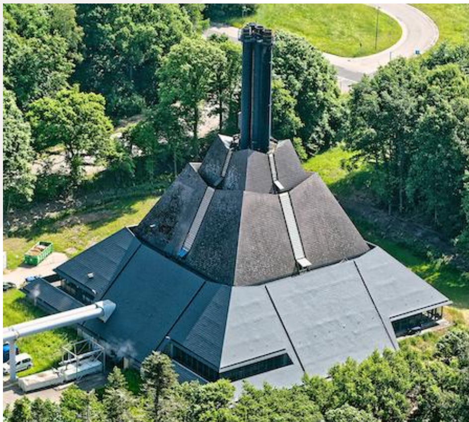
Chaufferie centrale du Sart Tilman
