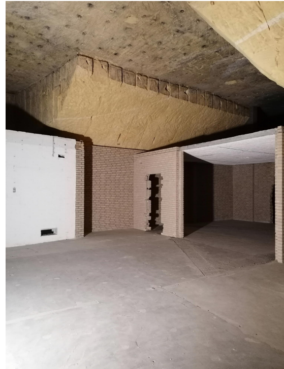
Fig. 9 : Paysage souterrain du NATO berg en 2022. On peut observer le sol en béton, les murs en briques et, au-dessus, le plafond de la carrière de tuffeau (Photo Ch. Caravello).
