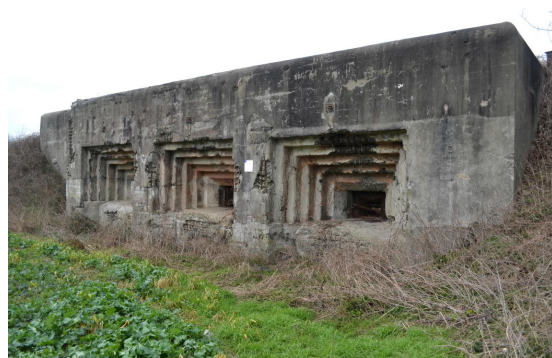
Fig. 8 - Casemate d'artillerie du Fort d'Eben-Emael en 2016. Le bunker contient trois canons et est relié au système de galeries du fort par un puits avec escalier et monte-charges pour les munitions (Photo K. Amendt).
