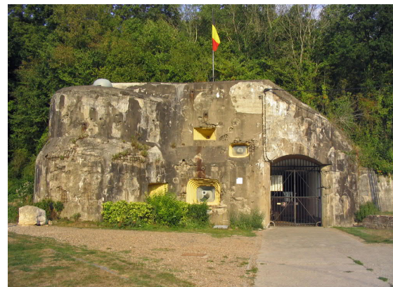
Fig. 2 : Le bunker avec l'entrée principale du Fort d'Eben-Emael en 2003. L'entrée mène à la caserne souterraine et au système de galeries souterraines du fort. Le bunker fait partie des défenses rapprochées du fort et est armé de mitrailleuses et de canons anti-char pour repousser une offensive terrestre (Photo K. Amendt).
