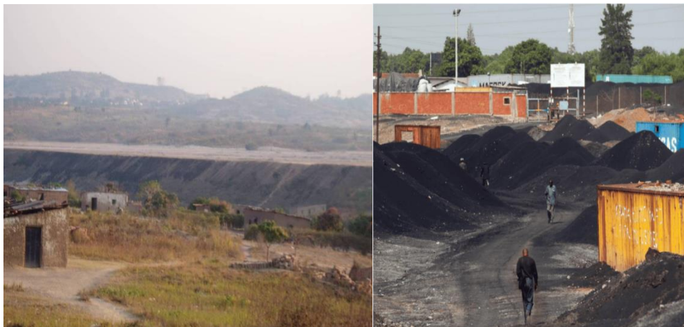
Figure 2-7. De gauche à droite : vue du bassin à rejet et depot de scoriés de l'usine de Shituru
