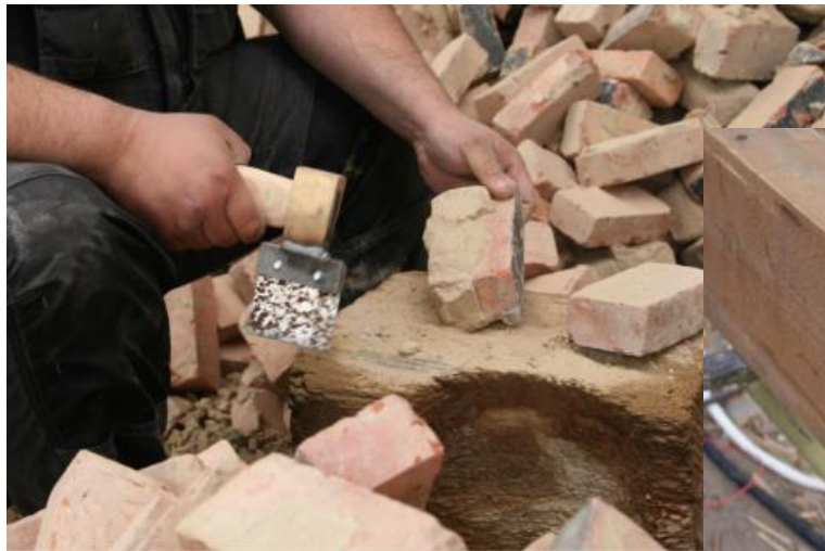
Nettoyage des restes de mortier
