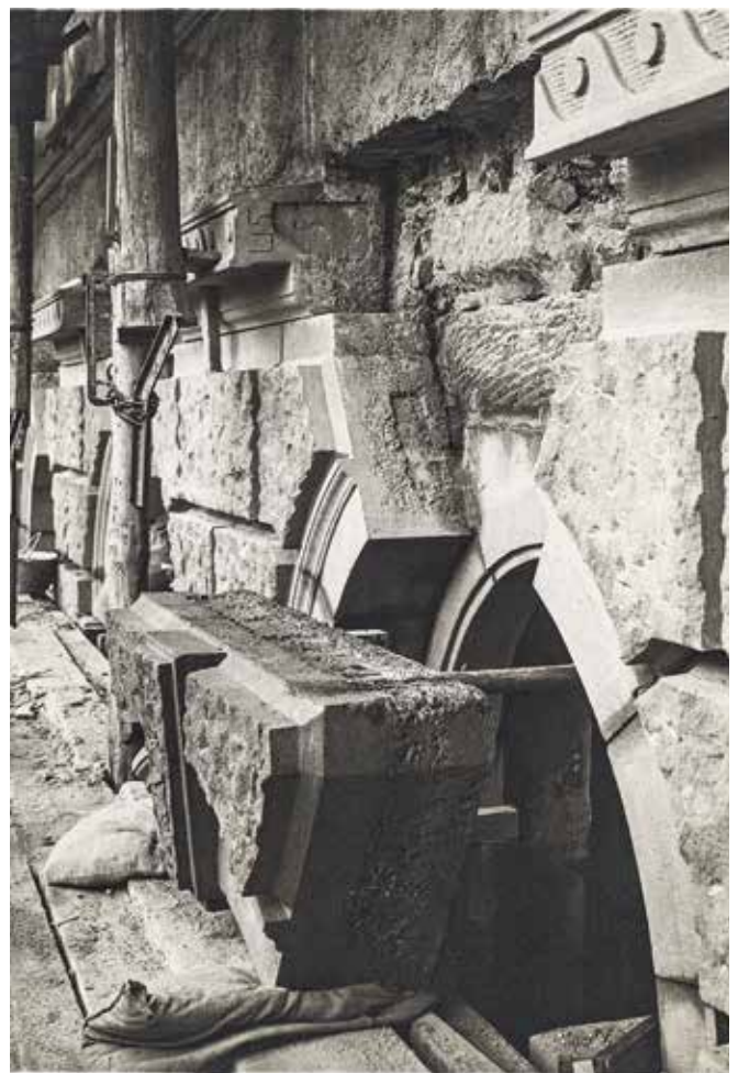
Pierres artificielles : Gustav Gull, extension/rénovation du bâtiment central de l'EPFZ, Zurich, 1914-1925 (GTA ARCHIV / ETH ZÜRICH, GOTTFRIED SEMPER)
