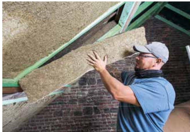
L'isolant est léger et flexible. Il est livré en panneaux de 60 x 1200 mm, avec une épaisseur allant 45 mm à 240 mm. (GRAMITHERM)
