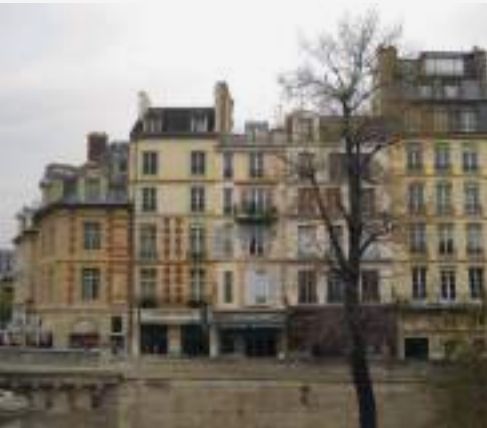
Immeubles surélevés, place Dauphine, Paris 1 er
