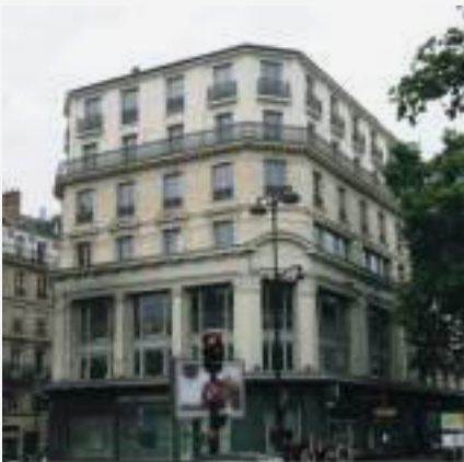
Bâtiment surélevé à 2 reprises, bld de Sébastopol, Paris 1 er
