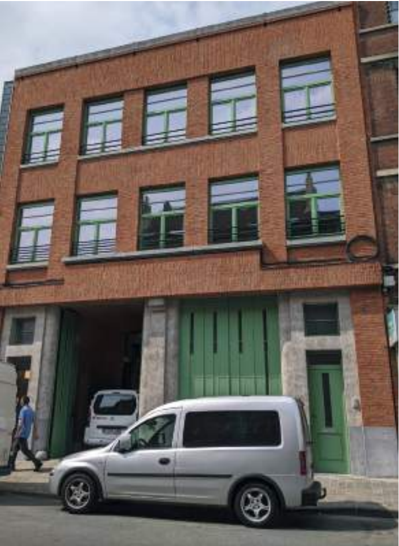
La rénovation d'un bâtiment de la STIB rue d'Anethan 42-44 à Schaerbeek.
