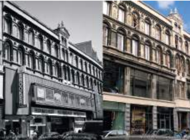
Les différentes catégories d’immeubles. Avant/après réhabilitations. © ERU
