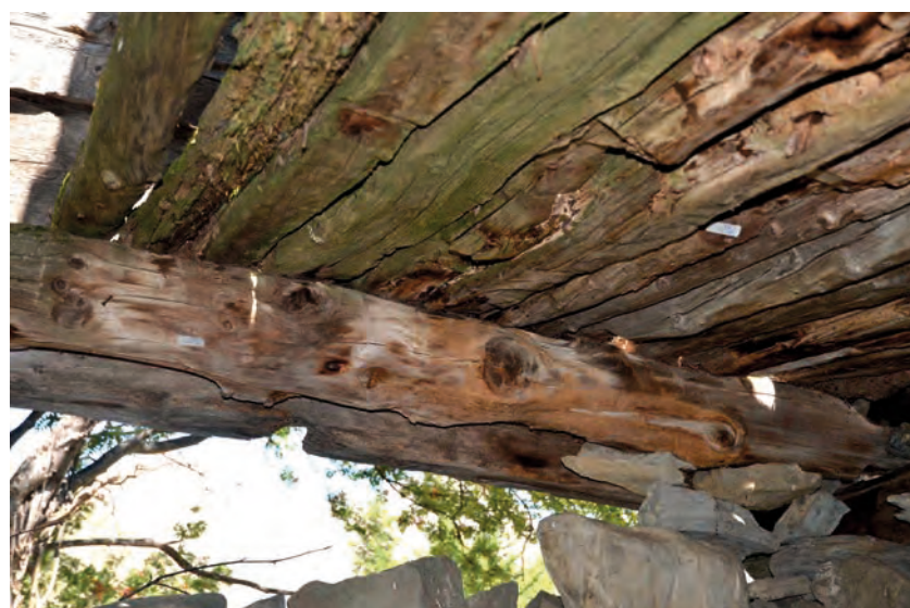
Poutre 11004 (R+0) Cliché de V. Labbas, 2012
