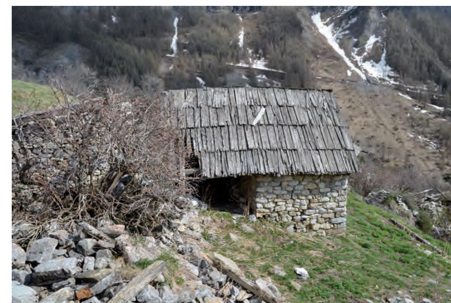
Mur nord ouest Cliché de V. Labbas, 2012
