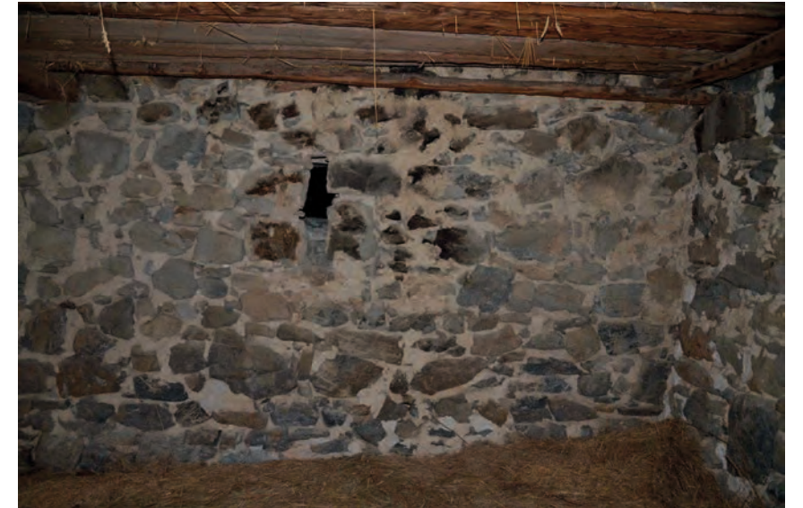
MR 1103, R+1, parement sud, partie est Cliché de V. Labbas, 2012
