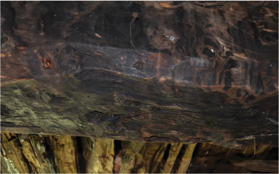
PLancher R0 : détail de la poutre 10501.
