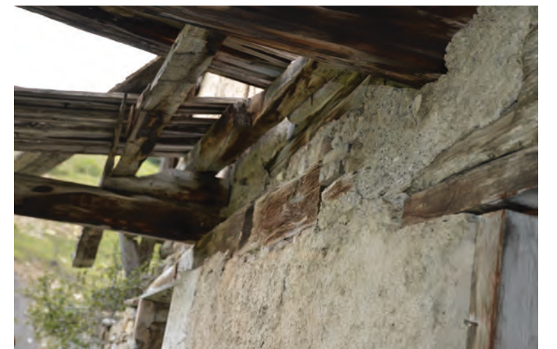
sablière de toiture réemployée en sablière de plancher.
