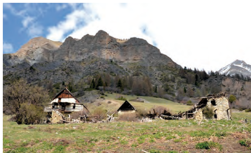
Vue d'ensemble prise du sud Cliché de V. Labbas, 2012
