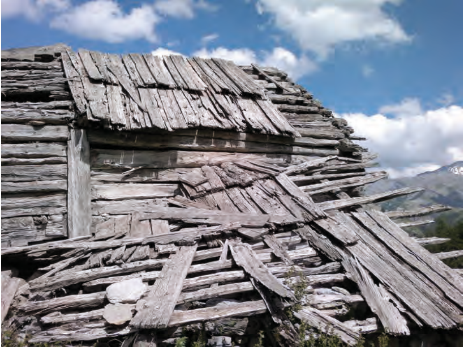
Façade ouest : niveau R+1 partie sud et toiture de l'annexis.
