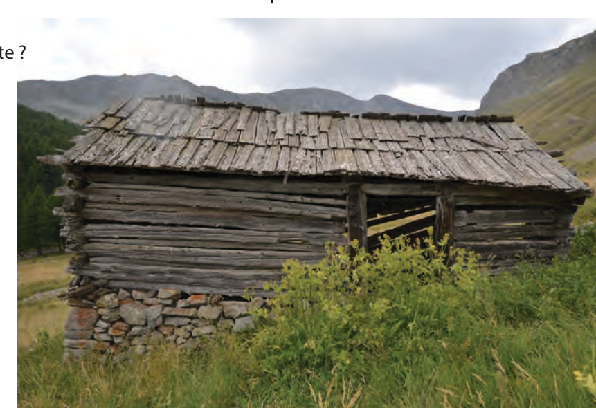
Mr 507 vue générale extérieure.
