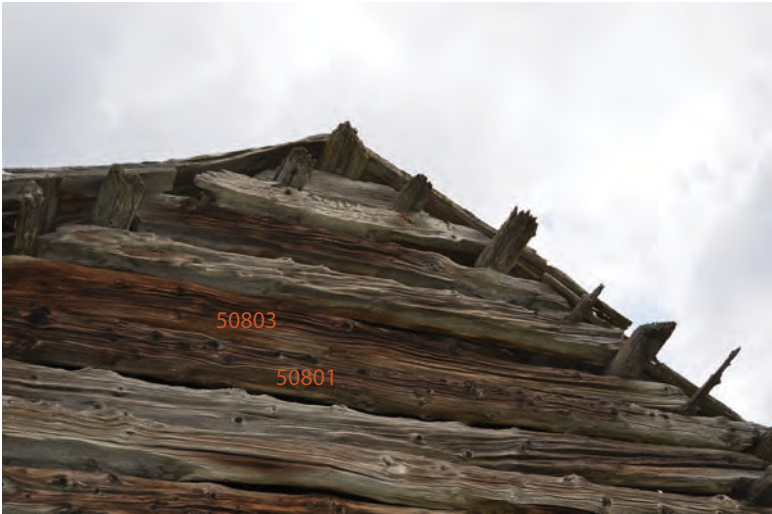
Mur 508, détail de la partie haute de l'élévation.
