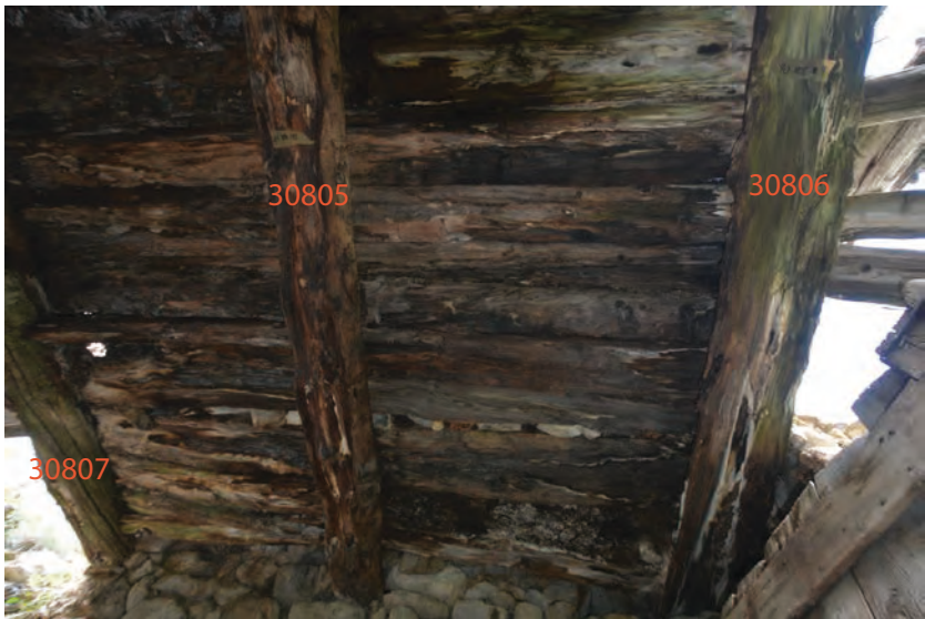
Vue d'ensemble du plancher 308.
