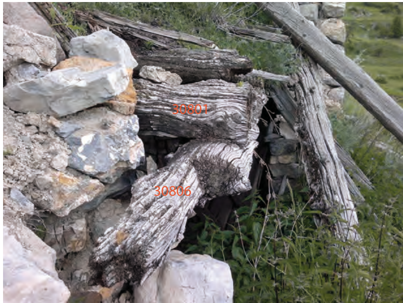
Plancher 308 : détail des bois 30806 et 30801.
