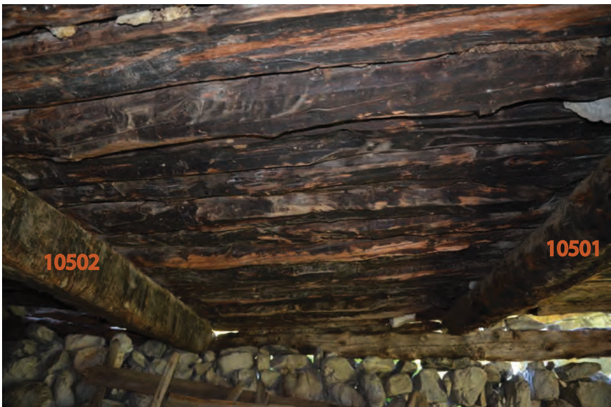
PLancher R0 : planches entre les poutres 10501 et 10502.
