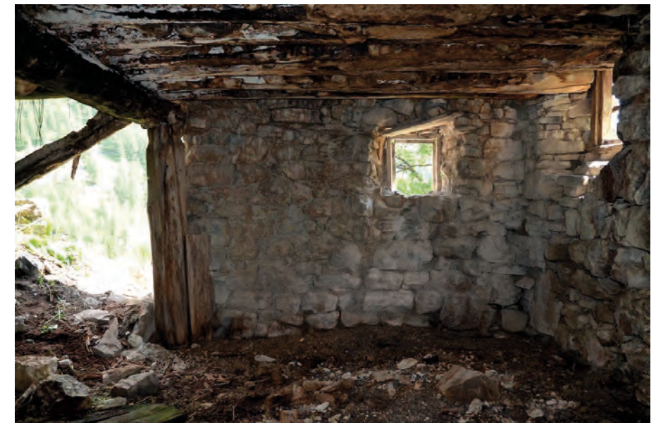
Mur MR502, partie ouest et poteau CR056 (US 50805) daté de 1534 (absence d'aubier). Cliché de V. Labbas, 2012.
