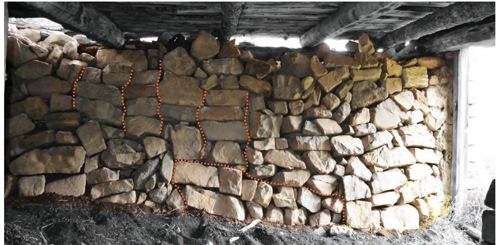
Mur 504, partie sud.
