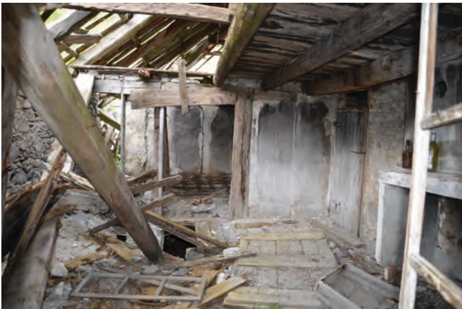
Plafond et pans de bois dans la pièce sud-ouest.
