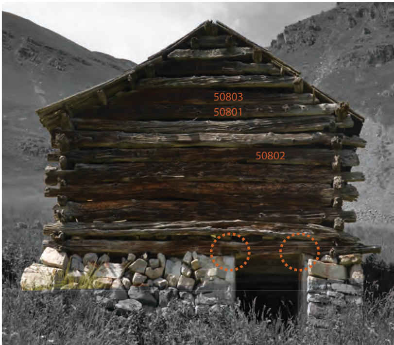
Élévation sud en 2012. Les cercles en pointillé rouge indiquent les mortaises sur le tirant-formant-linteau 50516 et marquant l'emplacement des chambranles disparus.
