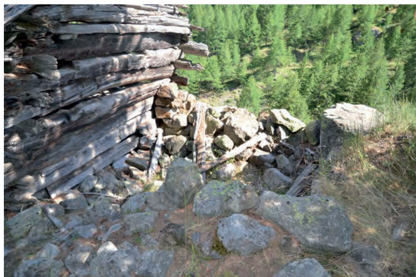
Vue d'ensemble de la structure accolée. Cliché de V. Labbas, 2012
