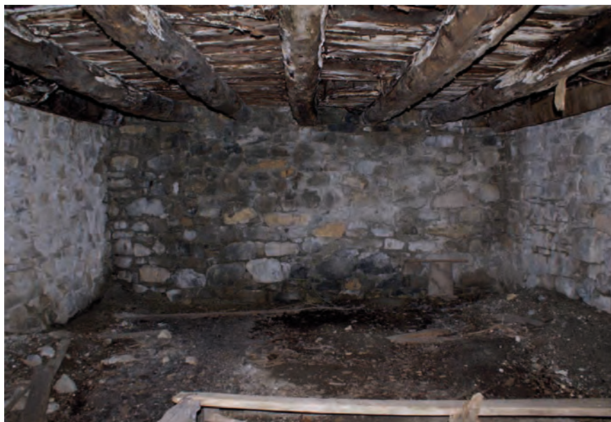
Détail mur nord Cliché de V. Labbas, 2012
