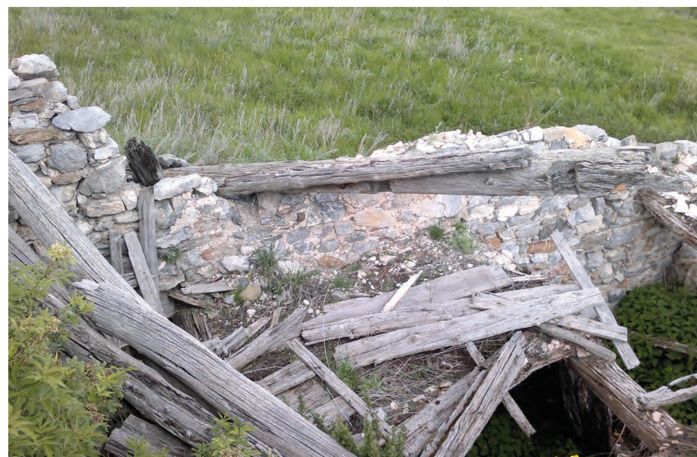
MR 302, parement interne au centre de l'élévation.
