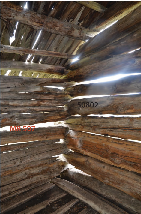
Mur 508, vue intérieure de l'angle est.
