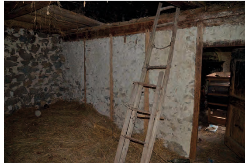
Cloison en pans de bois séparant le logis (R+1). Cliché de V. Labbas, 2012
