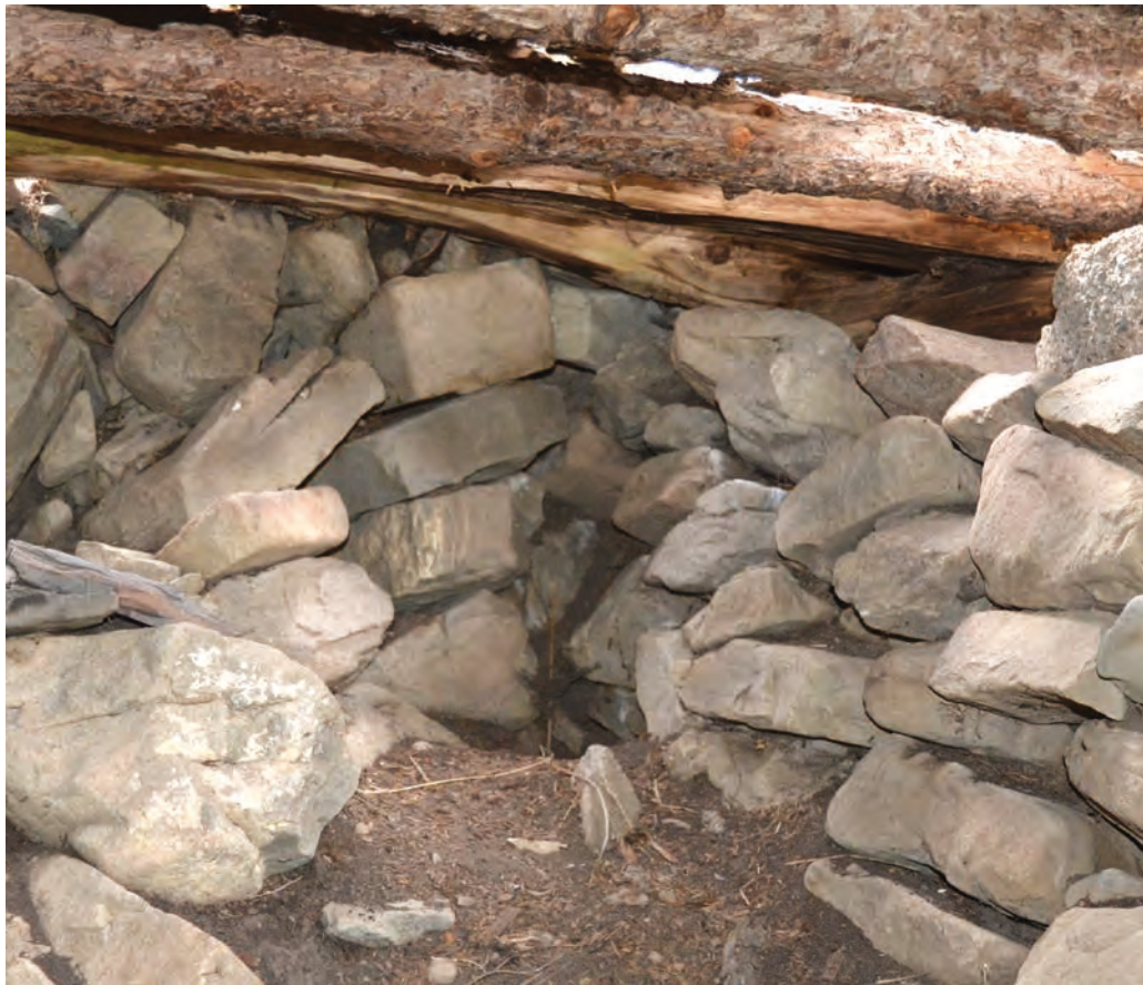
Détail de l'angle entre le mur nord 503 et le mur est 504.
