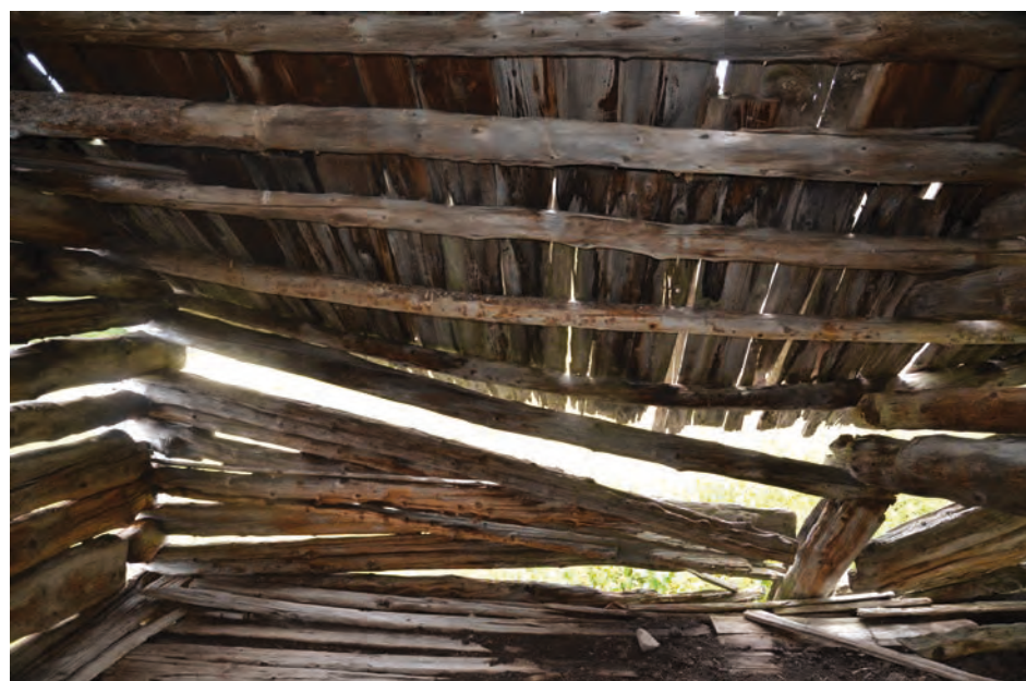
Mur 509 vue intérieure de la partie sud.
