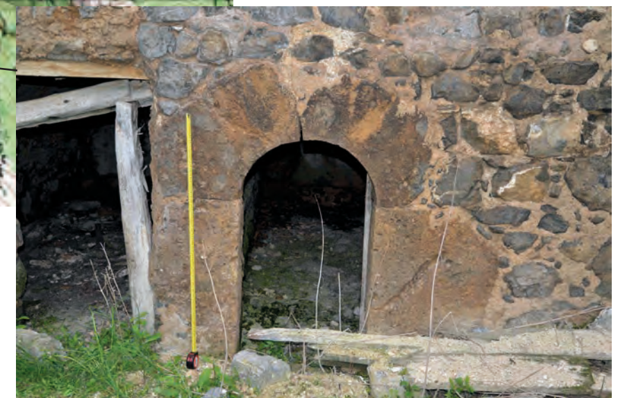
Travertin employée dans une baie (La Tour, Beuil) Cliché de V. Labbas, 2012
