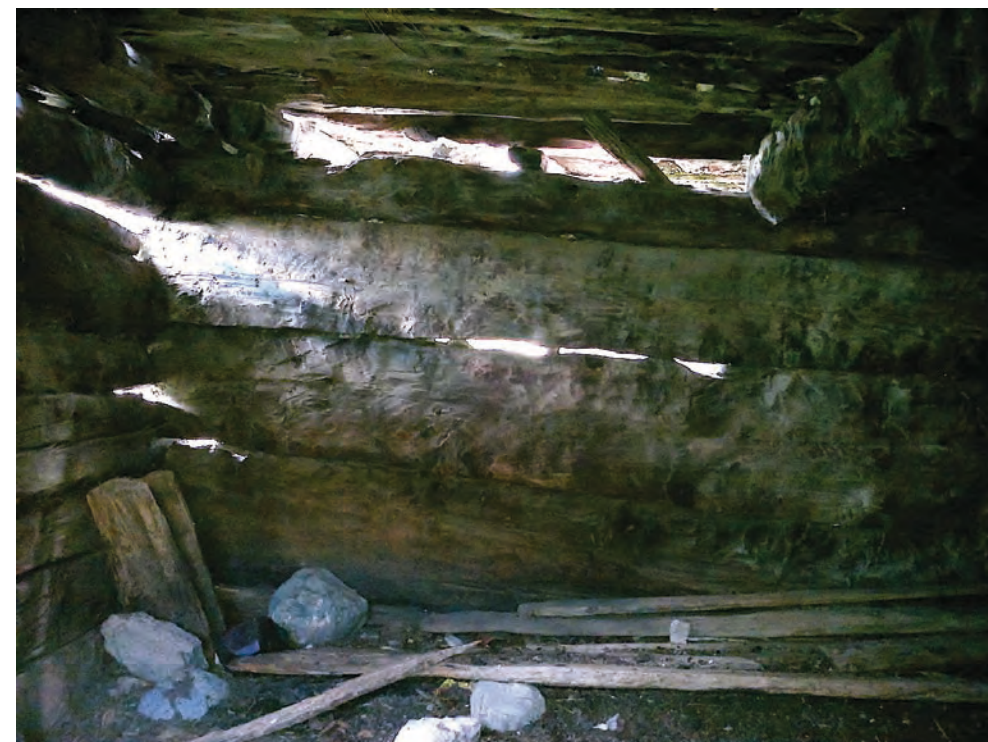
Mur ouest intérieur, partie sud. Détail au niveau du chainage sud.
