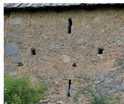
MR 1102, partie sud, détail de lucarne à R+2 et R+3. Cliché de V. Labbas, 2012
