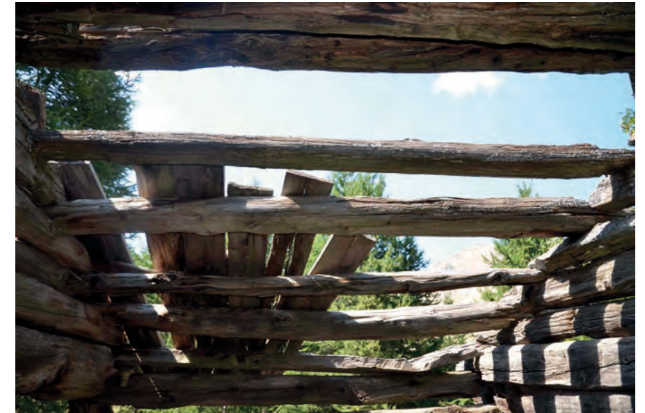
TO109, partie nord-ouest Cliché de V. Labbas, 2012
