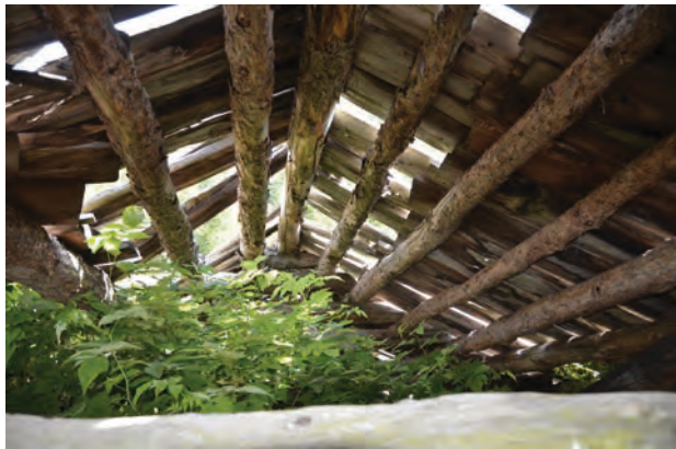
La toiture 412 vue depuis le nord.
