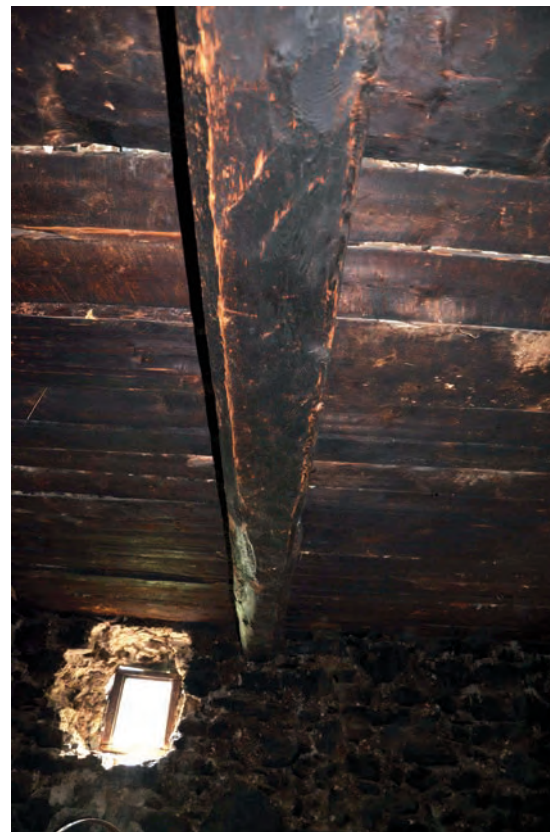
R+2, détail d'une poutre du plancher 1110 Cliché de V. Labbas, 2012
