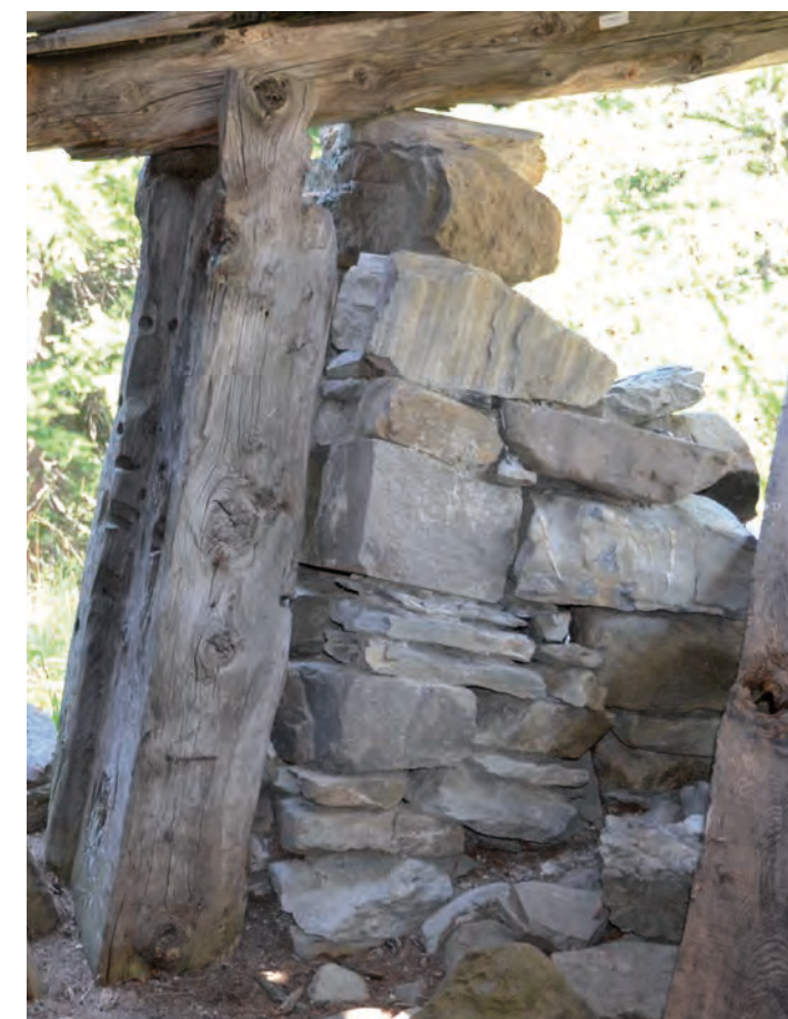
Détail piédroit et maçonnerie intérieur Cliché de V. Labbas, 2012
