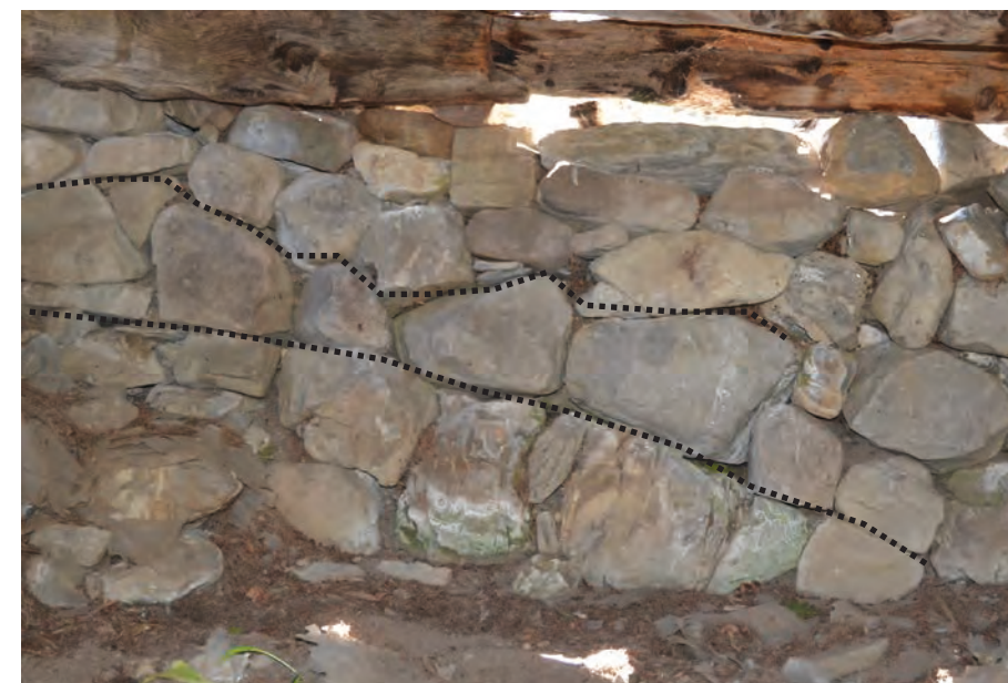
Parement interne : détail des assises obliques
