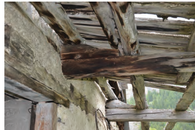
Extrémités de chevrons réemployés dans la poutraison du balcon supérieur.
