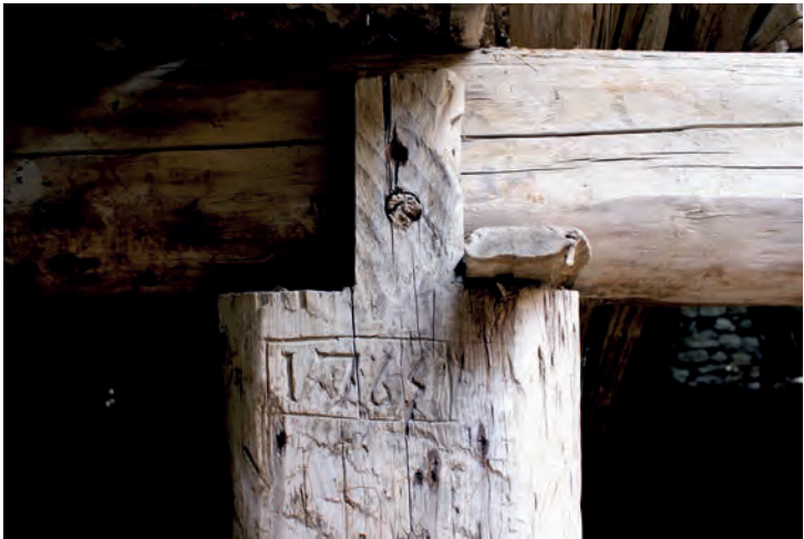
Poteau en bois gravé de la date 1765, niveau R0. Cliché V. Labbas, 2012.
