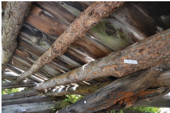
Détail de la pente ouest de la toiture 412.
