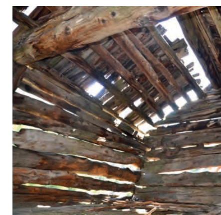
MR106, partie sud (articulation avec MR107 et TO109). Cliché de V. Labbas, 2012
