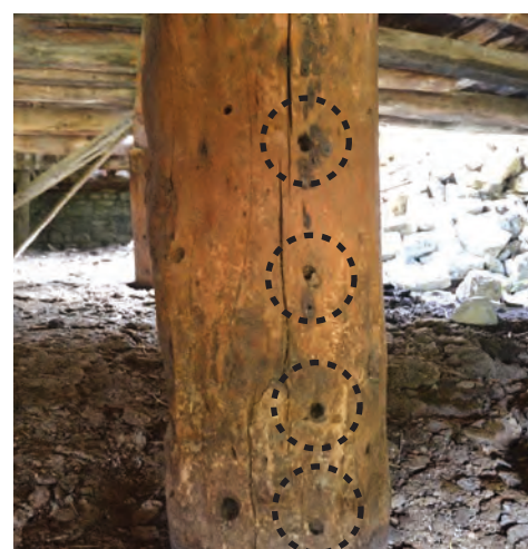
Trous dans le poteau 10204 (négatif d'une ancienne cloison ou barrière).
