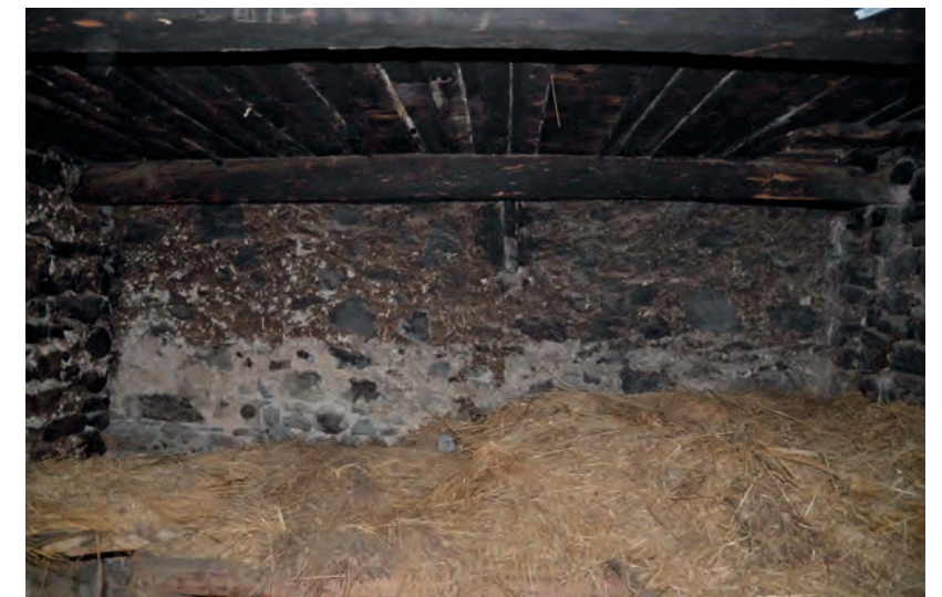
MR 1103, R+2, parement sud Cliché de V. Labbas, 2012
