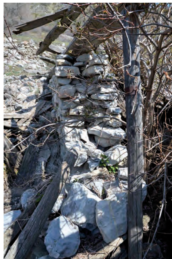
MR 503, vue transversale nord Cliché de V. Labbas, 2012
