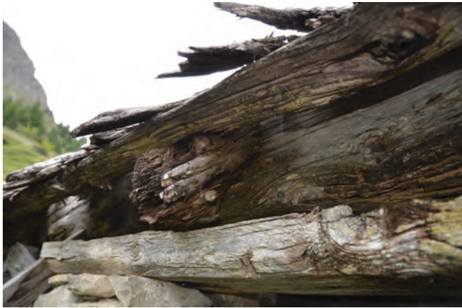
Articulation sablière / arbalétrier / panne / bardeaux de la toiture.
