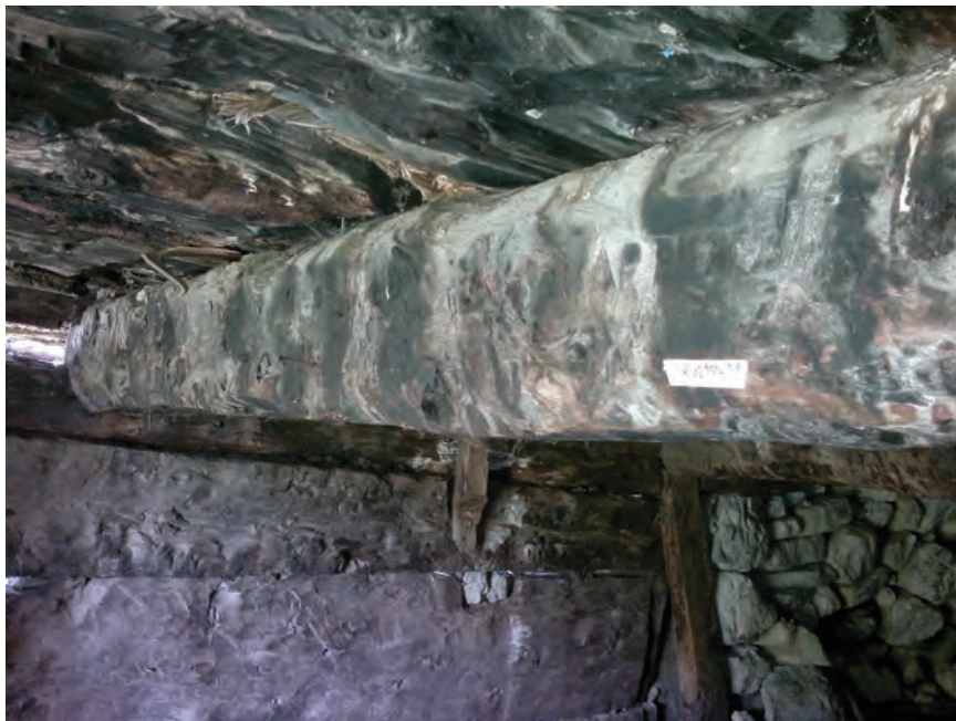
PLancher R0 : détail de la poutre 10501.
