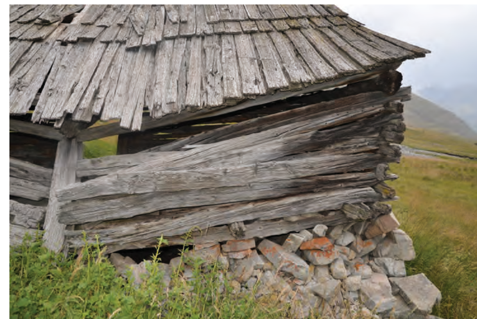
Mur 509 vue extérieure de la partie sud.
