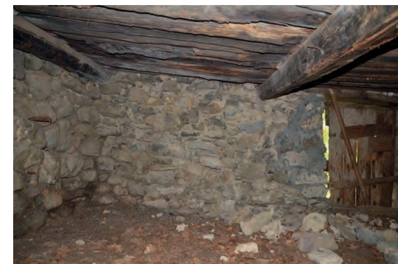
MR 1102, parement interne, R+2 partie sud Cliché de V. Labbas, 2012
