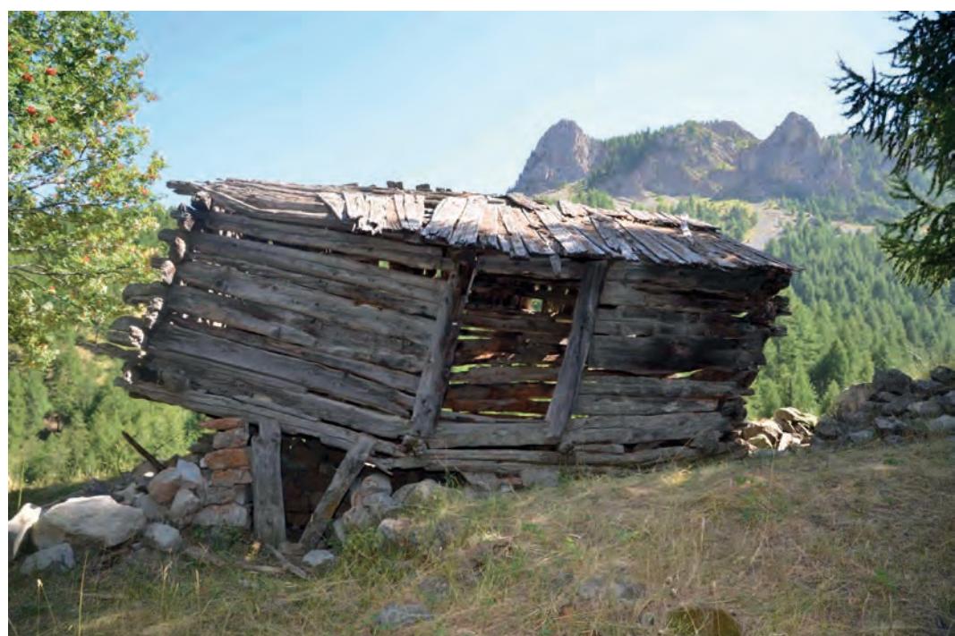
Vue du mur ouest.
