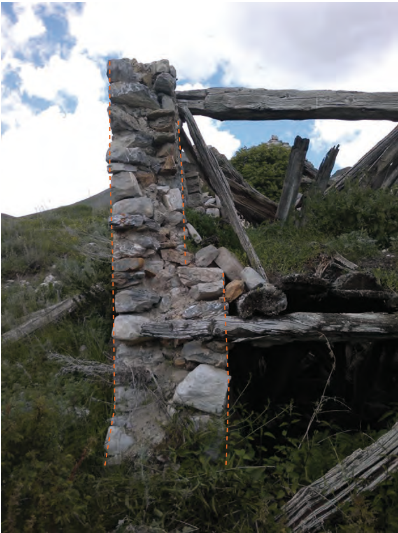
Vue en coupe du mur 304 au sud du mur 303.
