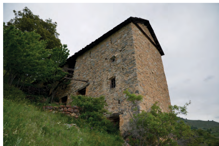
Vue du sud ouest. Cliché de V. Labbas, 2012
