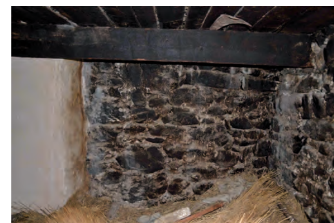
MR 1106, parement nord, R+2, partie ouest Cliché de V. Labbas, 2012
