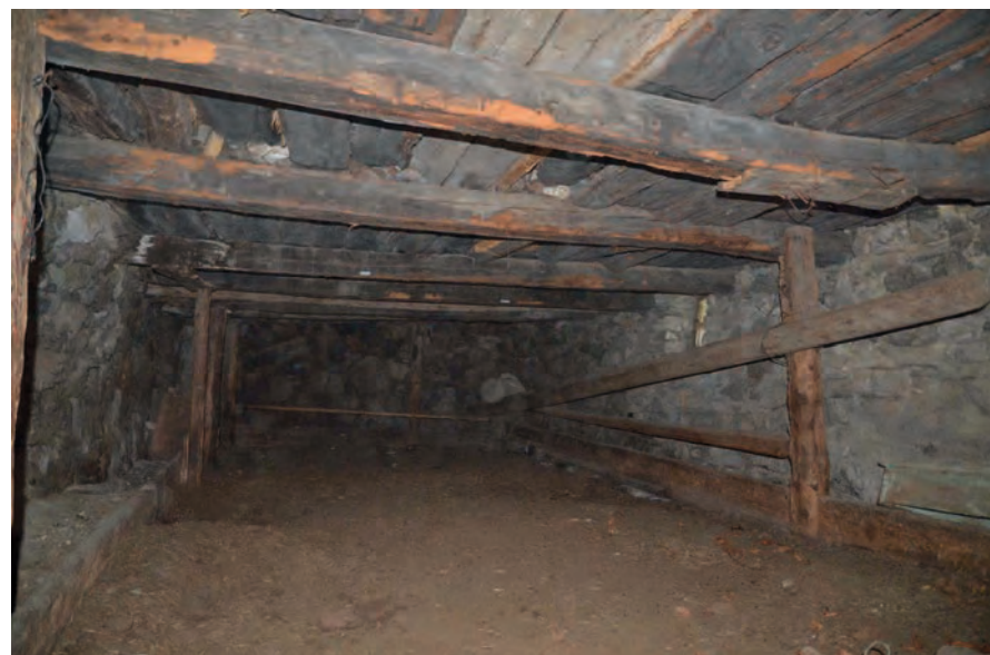
R+1, partie nord, vue générale Cliché de V. Labbas, 2012
