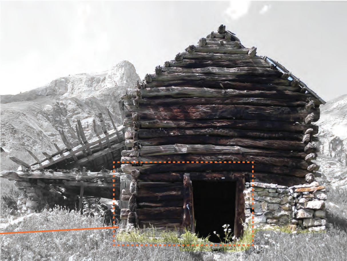
Vue d'ensemble de la façade sud.
