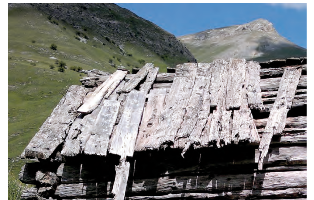
Niveau R+1, détail de la couverture en bardeaux dans la partie nord ouest.
