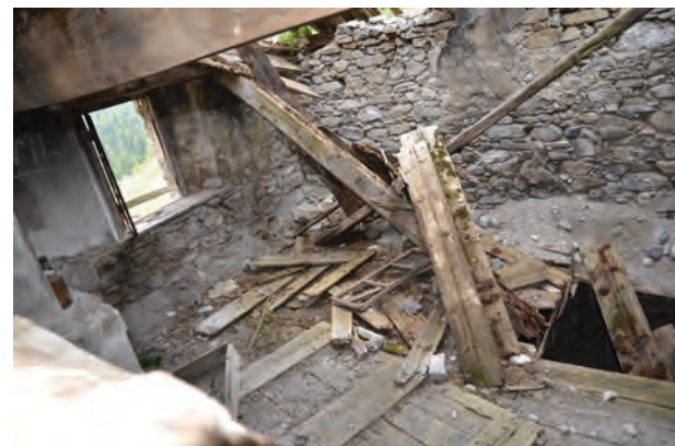
Pièce sud-ouest, vue du pignon sud et gouttereau ouest.
