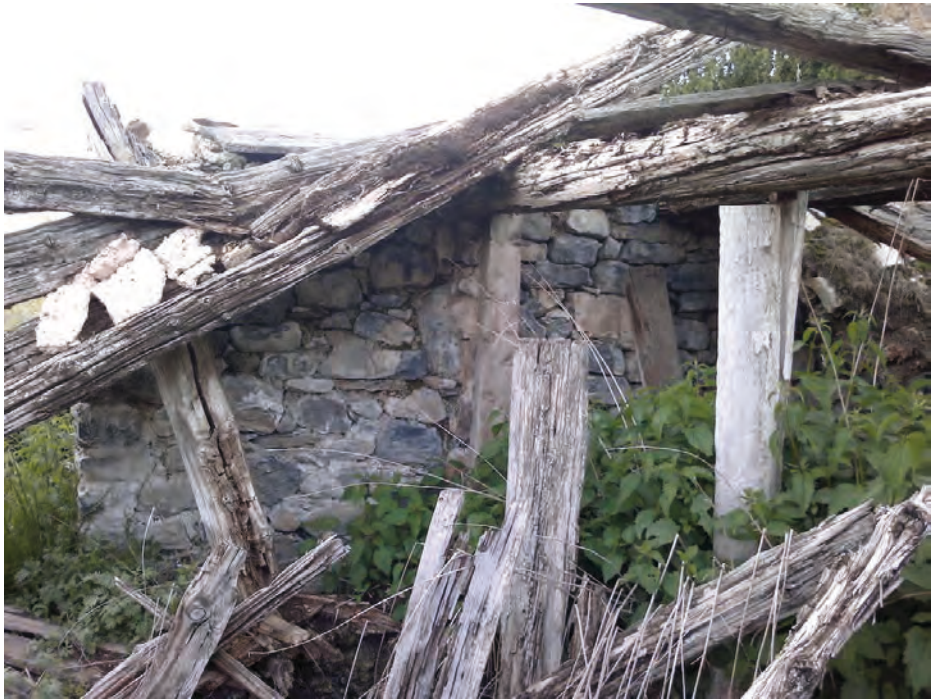
Parement intérieur au centre de l'élévation
