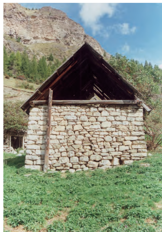
Mur sud Cliché d'après PNM 2001, 2012
