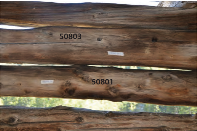
Mur 508, vue intérieure. Détail des bois 50801 et 50803.
