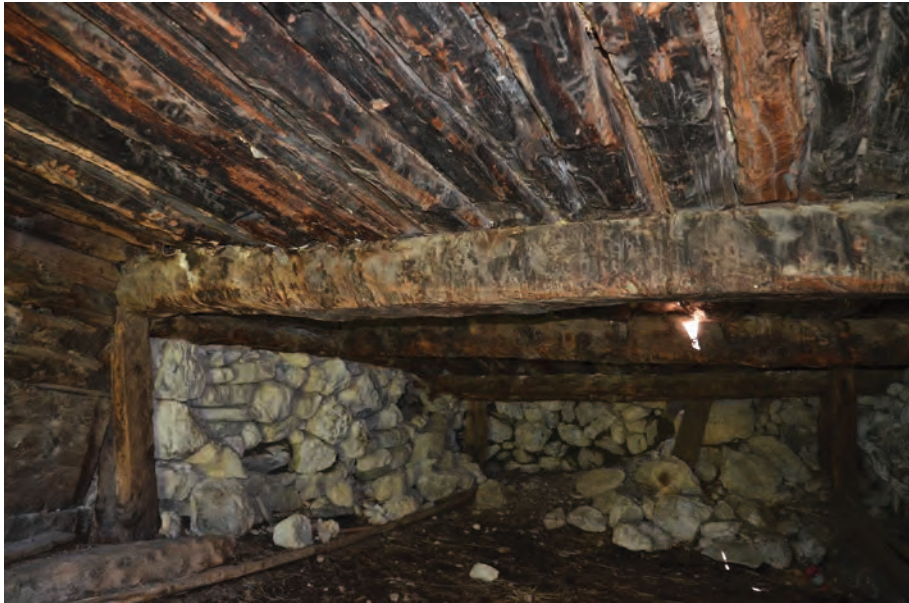
PLancher R0 : vue de la partie nord.
