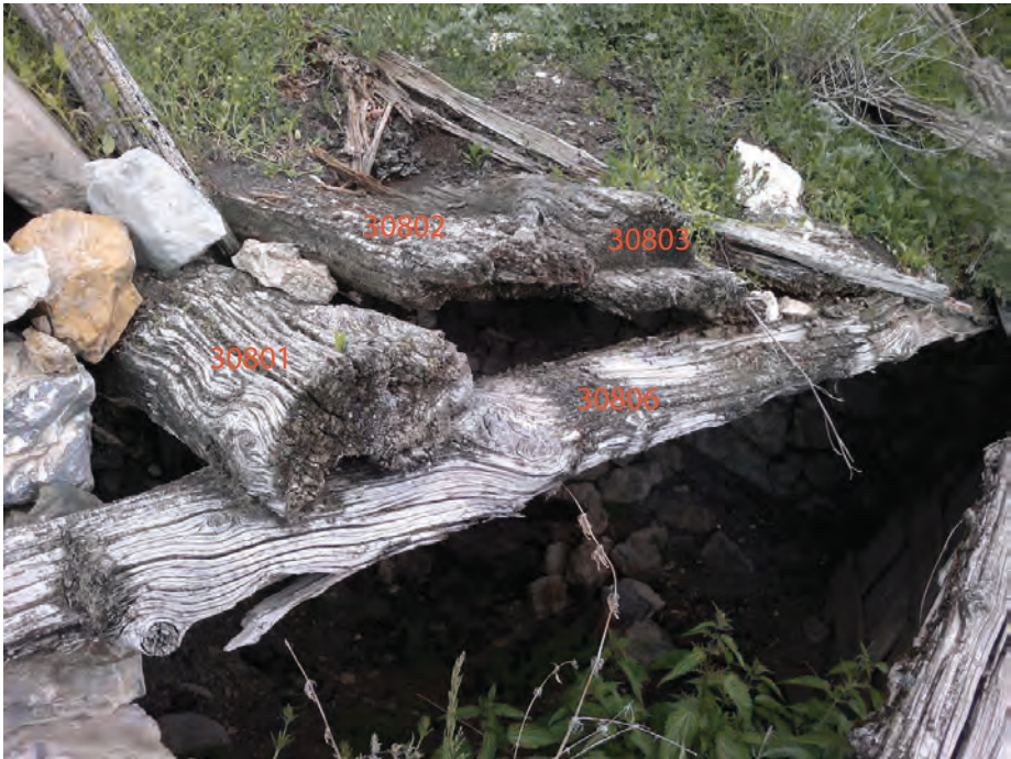
Plancher 308: poutre 30806 et planches 30801, 30802 et 30803.
