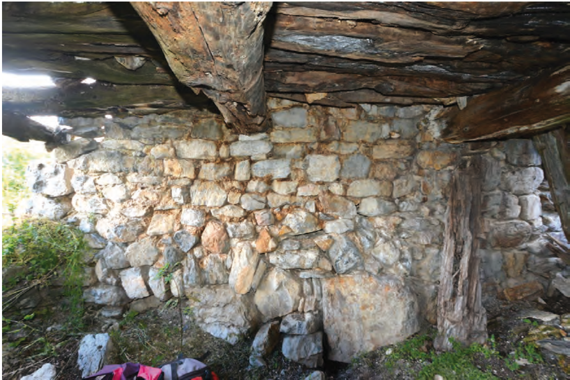
Vue du parement intérieur en R 0 dans la partie est.
