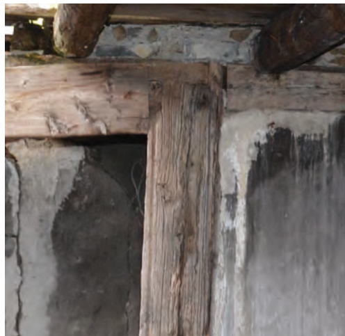
Bardeau de toiture réemployé dans un chambranle. Pièces sud ouest.
