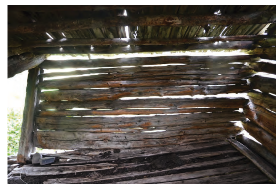
MR 507 vue intérieure de la partie sud.
