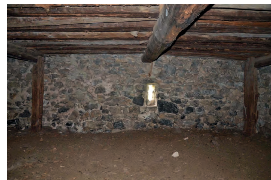
MR 1102, parement interne, R+2 partie nord Cliché de V. Labbas, 2012
