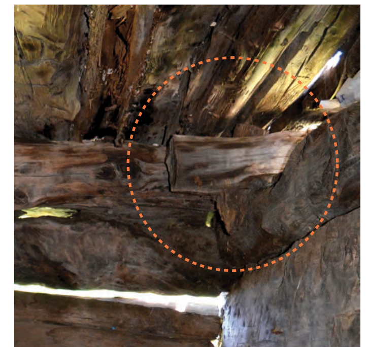
Détail de l'extrémité de la poutre sud harpée dans le mur 104 de la grange.
