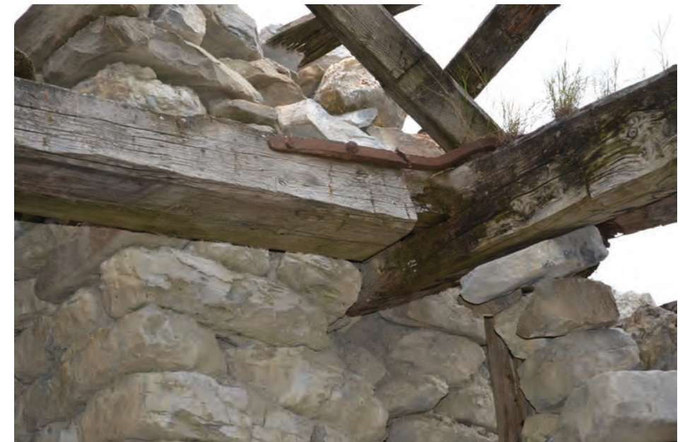
Eléments de charpente de la maison Rebattu plantés dans le mur antérieur.
