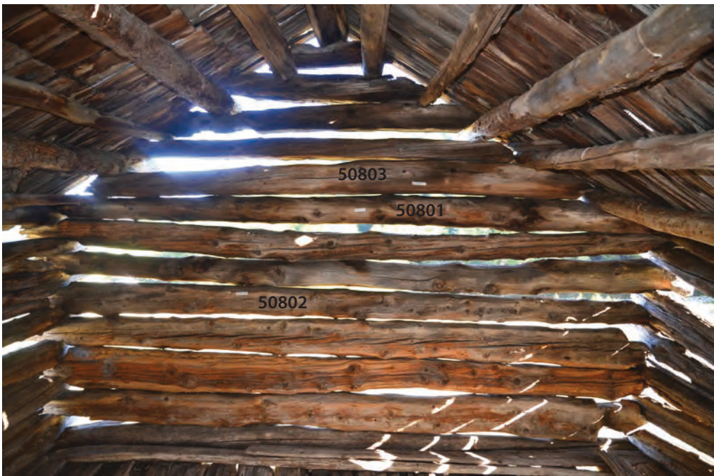
Mur 508, vue intérieure.
