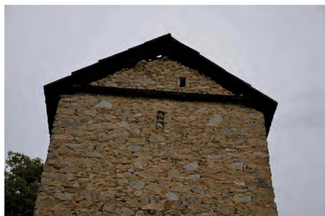
MR 1106, parement sud, partie haute Cliché de V. Labbas, 2012
