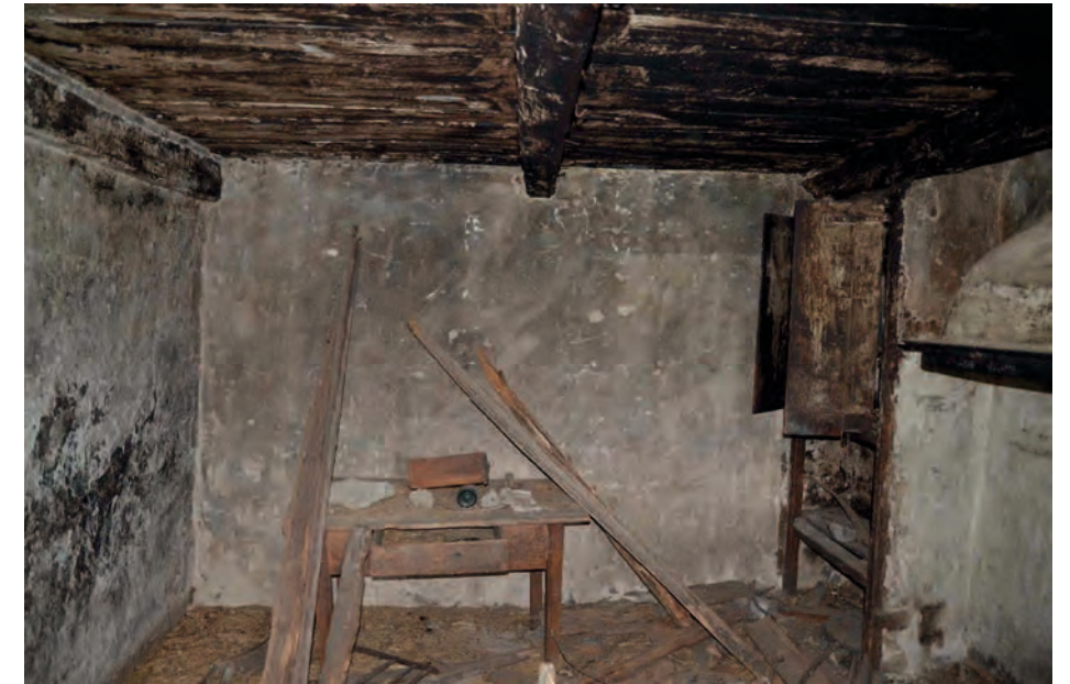
MR 1105, parement interne enduit, R+1 (logis) Cliché de V. Labbas, 2012
