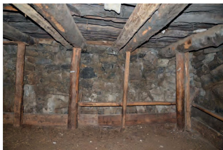
MR 1104, partie nord, parement interne Cliché de V. Labbas, 2012
