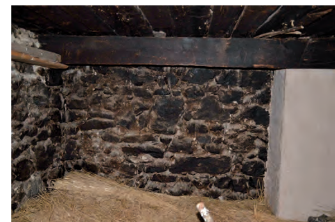
MR 1106, parement nord, R+2, partie est Cliché de V. Labbas, 2012
