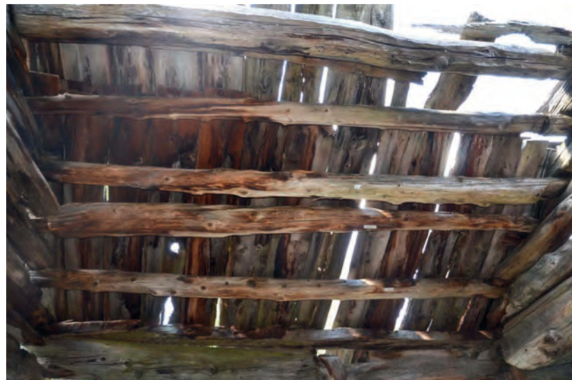
TO 109, partie sud-est Cliché de V. Labbas, 2012
