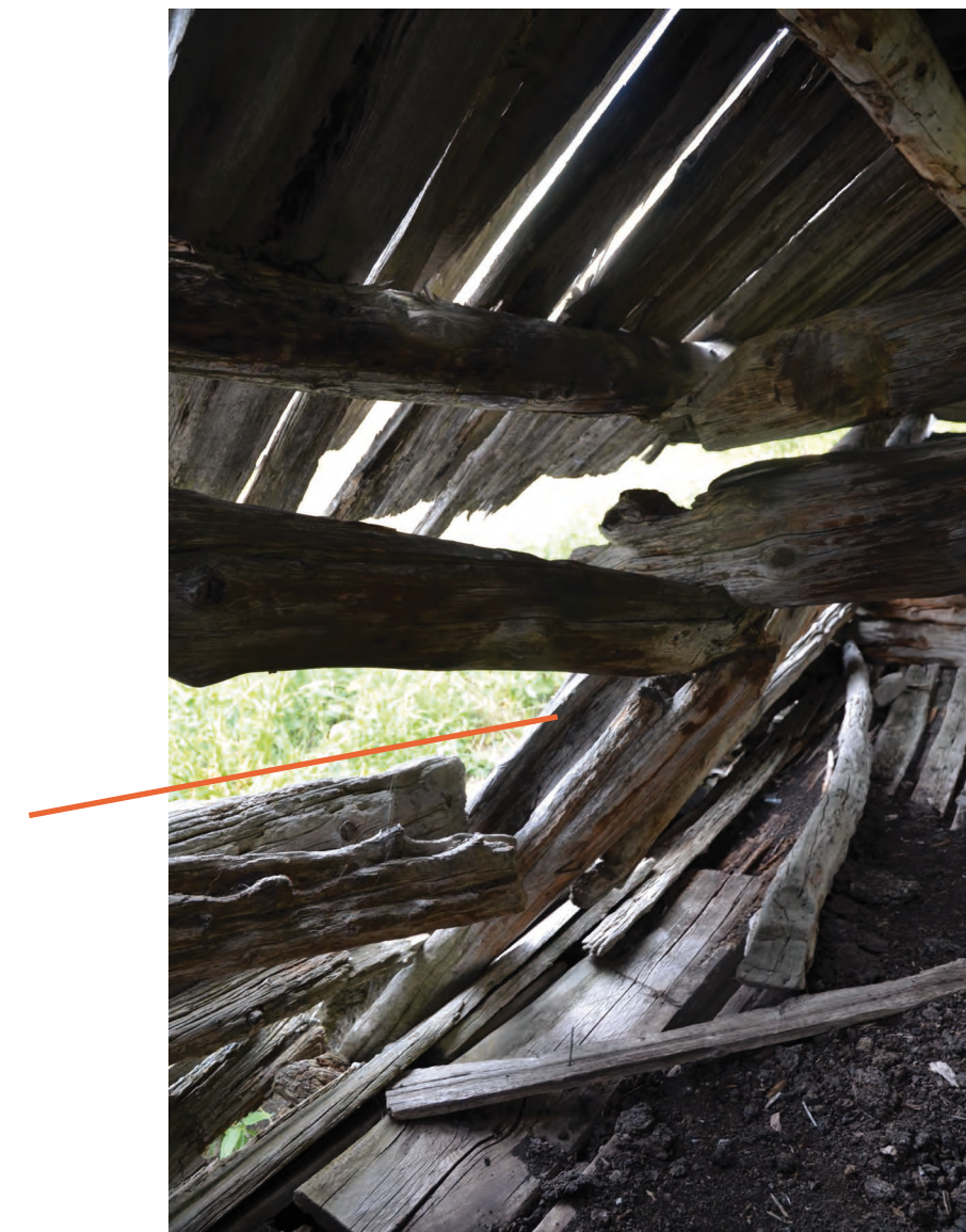
Mur 509, détail de la partie centrale de l'élévation.
