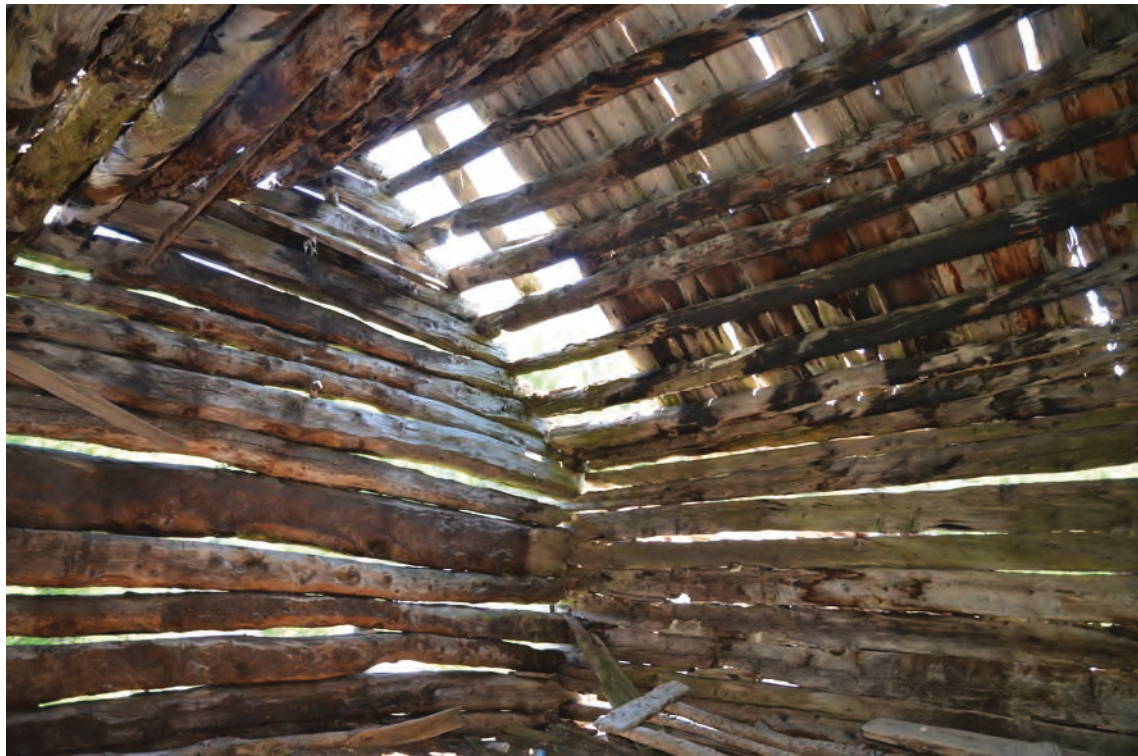
Niveau R+1, vue de l'angle sud ouest.
