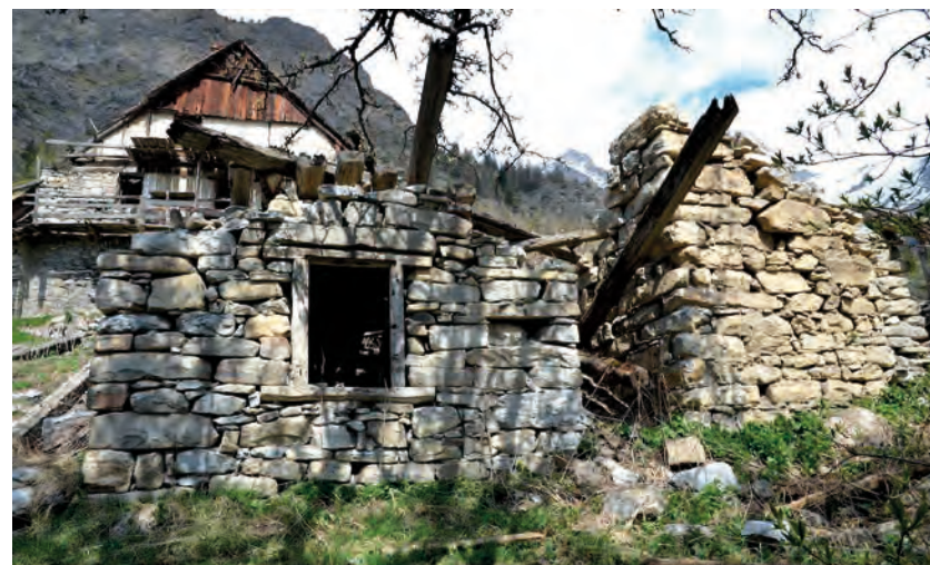
Vue des unités 1 et 2 Cliché de V. Labbas, 2012
