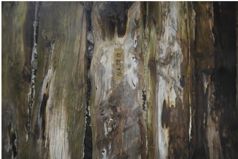
Plancher 308 : détail de la planche (lambourde) 30808.
