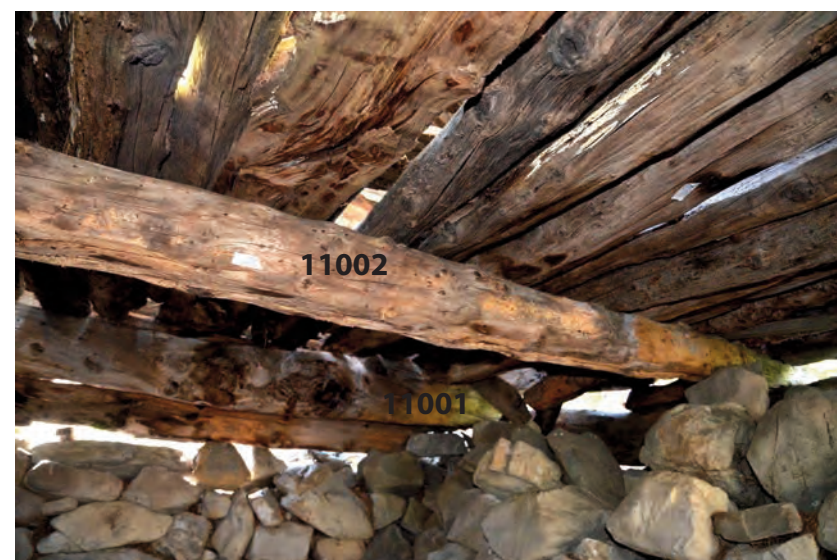
Poutre 11002 et 11001 (R+0) Cliché de V. Labbas, 2012
