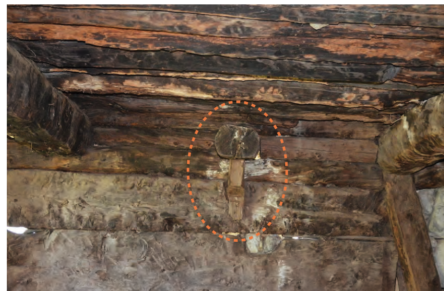
Détail de l'extrémité de la poutre 10801 fixée à la grange par une agrafe.
