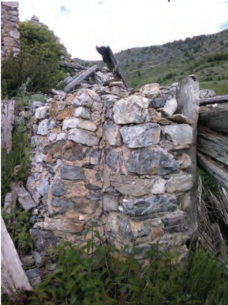
Confortement du mur 304
