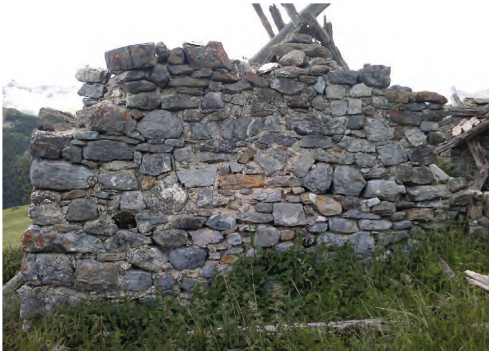
MR 302, partie est du parement externe
