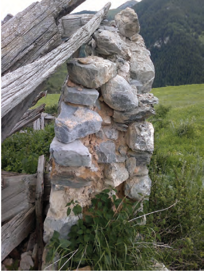
Mur 304 vue en coupe dans la partie est.
