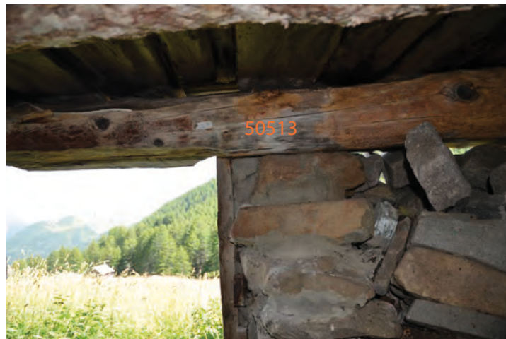
Plancher 505: Poutre formant linteau 505 13.
