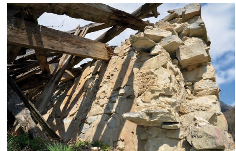
Détail d'une fenêtre obturée au sud Cliché de V. Labbas, 2012
