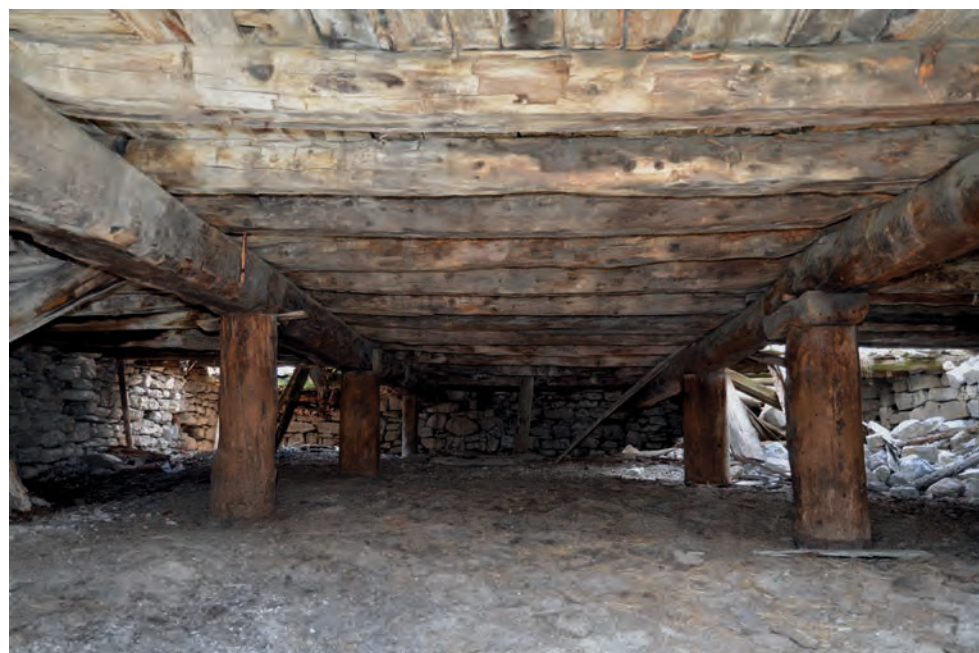
CR 100 : plancher, niveau R0 Cliché V. Labbas, 2012
