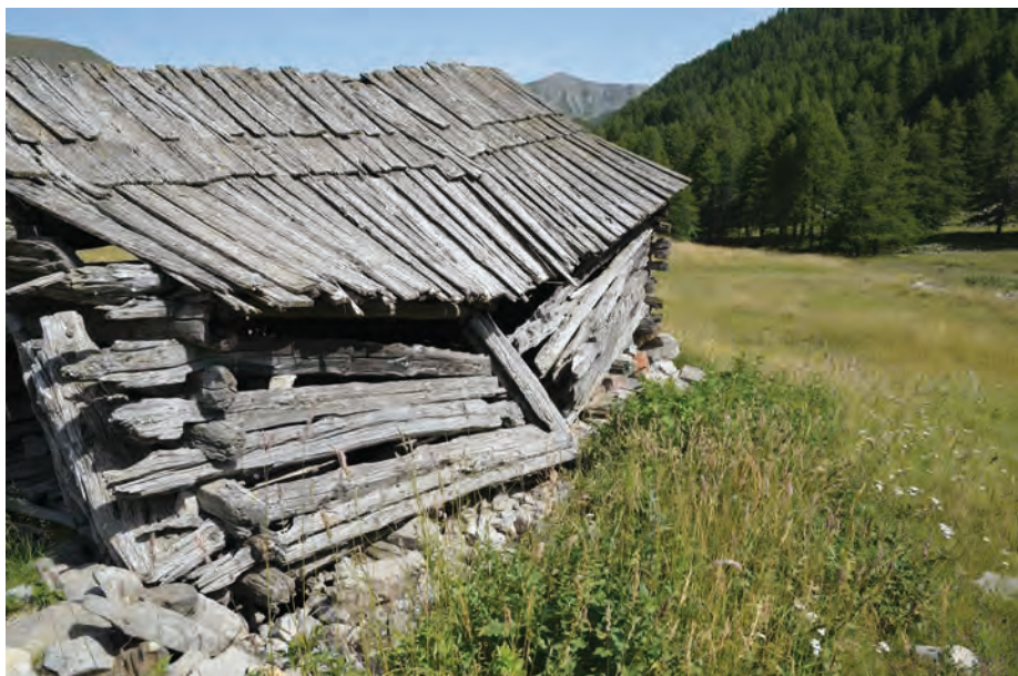
Mur 509 vue du nord.
