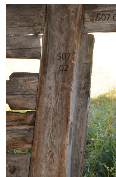
Mur 507, détail du linteau 50701 et du chanbranle 50702 vue de l'intérieur.
