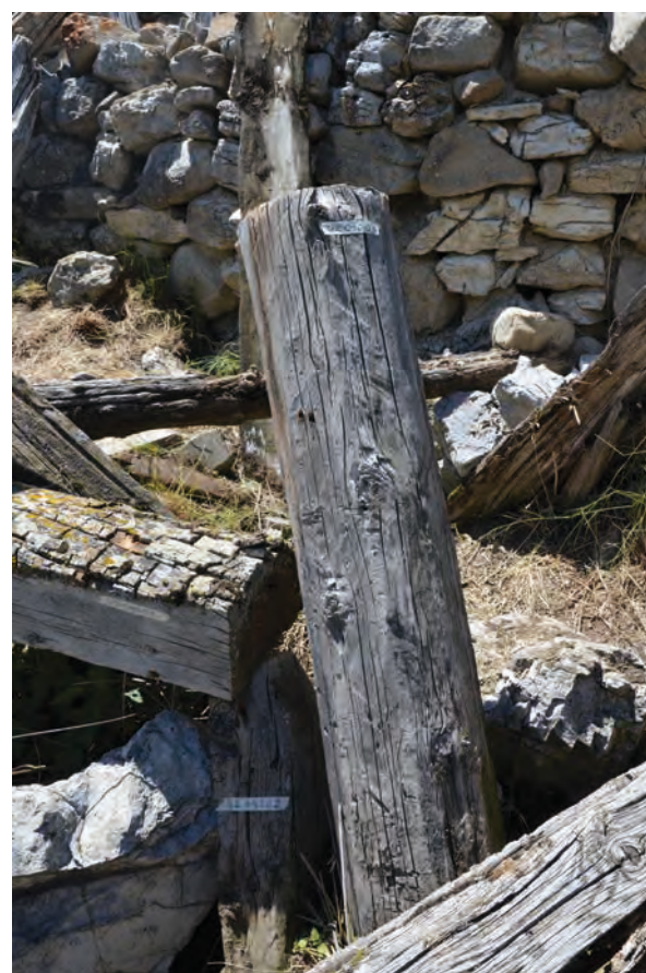
Maison Raynaud: détail d'un poteau et d'une cale
