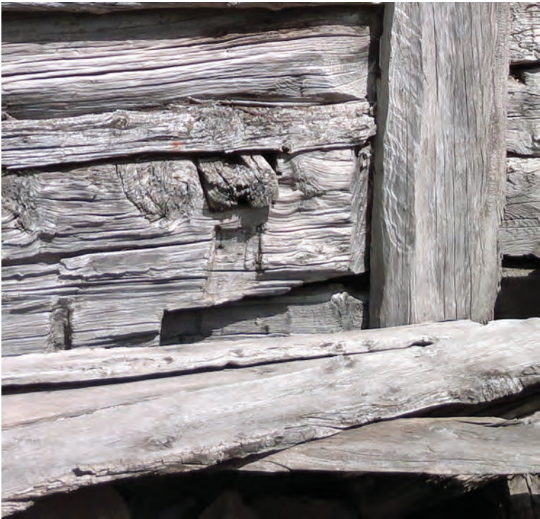
Détail d'une maille en réemploi glissée dans le poteau rainuré
