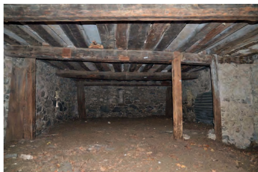
R+2, vue générale sud Cliché de V. Labbas, 2012
