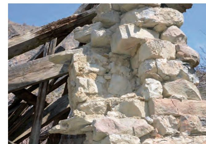
Comblement de la fenetre est (US 50213). Cliché de V. Labbas, 2012
