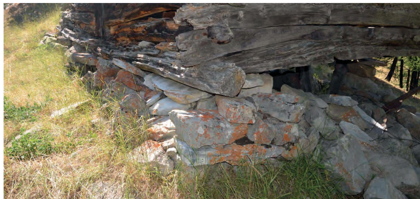
Vue de l'angle sud entre MR 102 et MR 101. Cliché de V. Labbas, 2012
