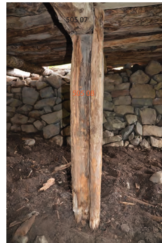
Plancher 505: Pilier 505 08 et poutre 505 07.
