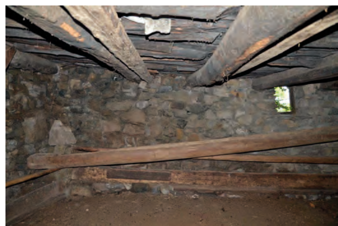
MR 1102, partie nord, parement interne Cliché de V. Labbas, 2012
