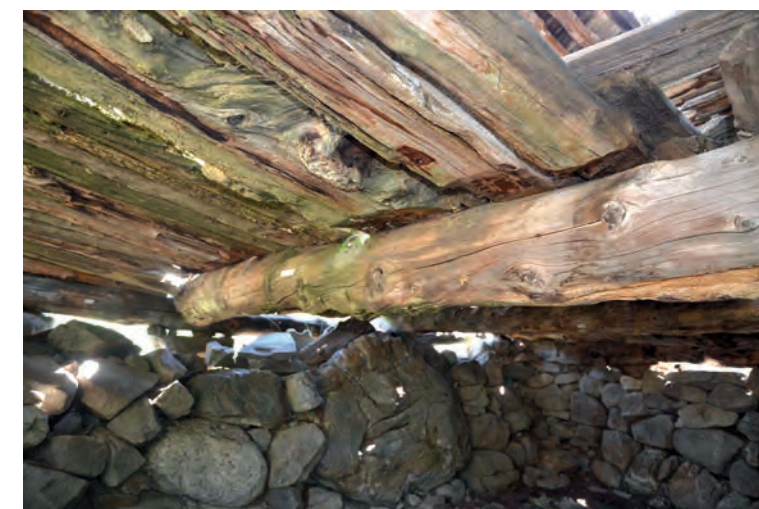
Poutre 11003 (R+0). Cliché de V. Labbas, 2012
