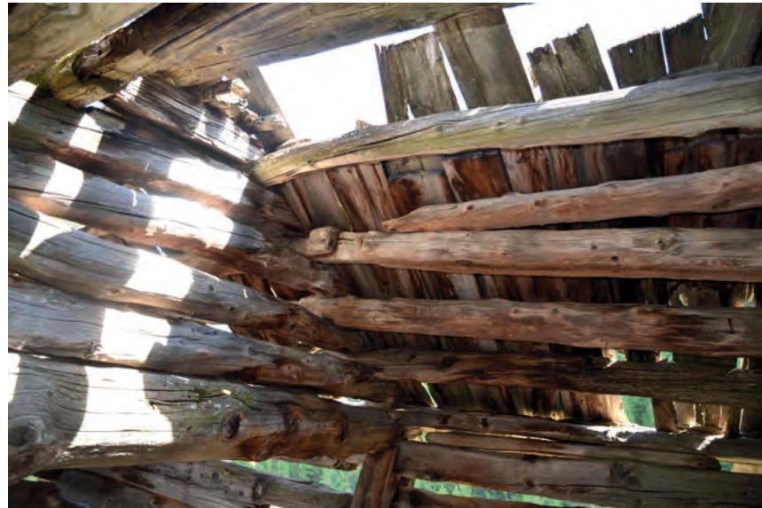
Toiture TO109 et S 111, vue du sud-ouest. Cliché de V. Labbas, 2012
