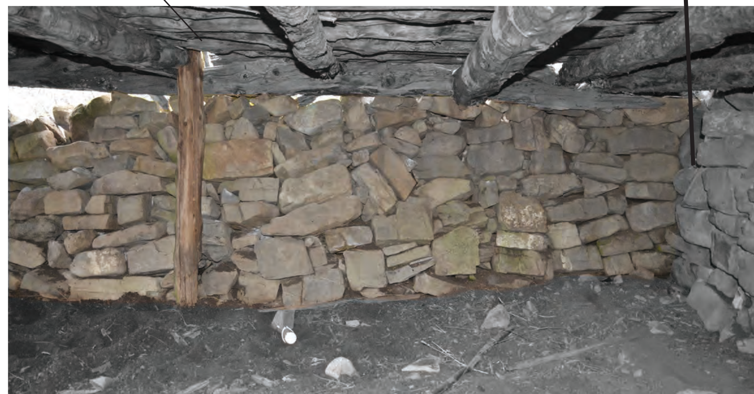
MR 502 vue du parement intérieur, partie nord.
