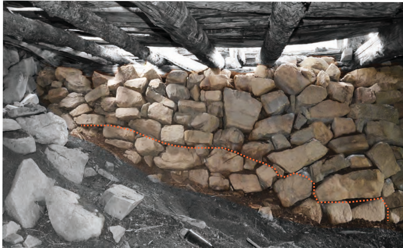
Mur 504, partie nord.
