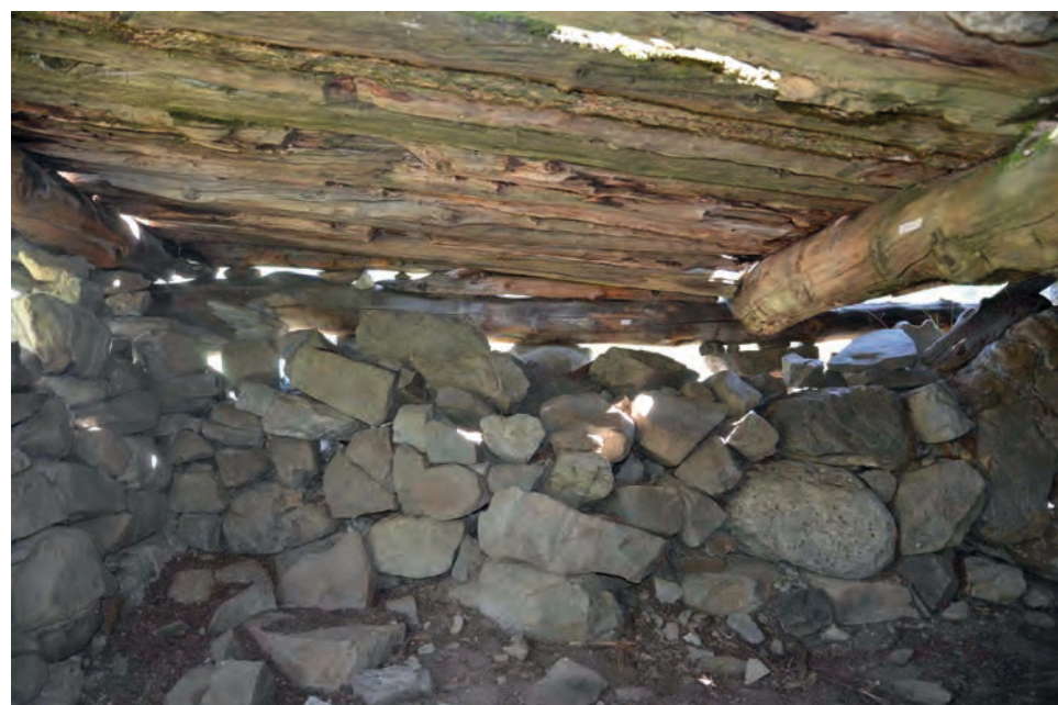
MR102, partie nord Cliché de V. Labbas, 2012
