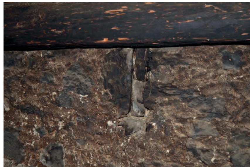
MR 1103, fenêtre obturée, R+2, parement sud Cliché de V. Labbas, 2012
