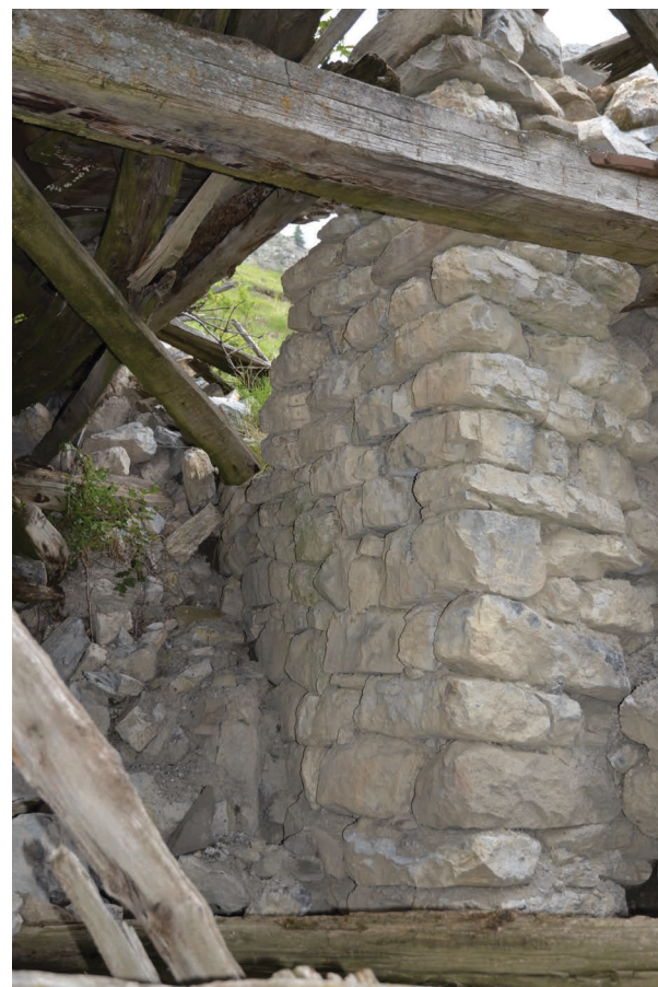
Vue du parement ouest du mur préexistant à la maison Rebattu.
