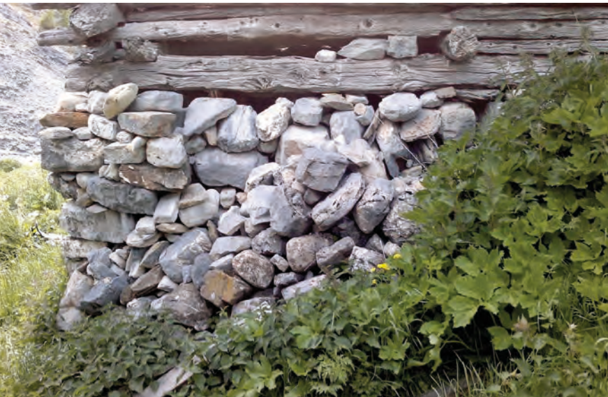
Parement externe du soubassement en pierre sèche (R0).
