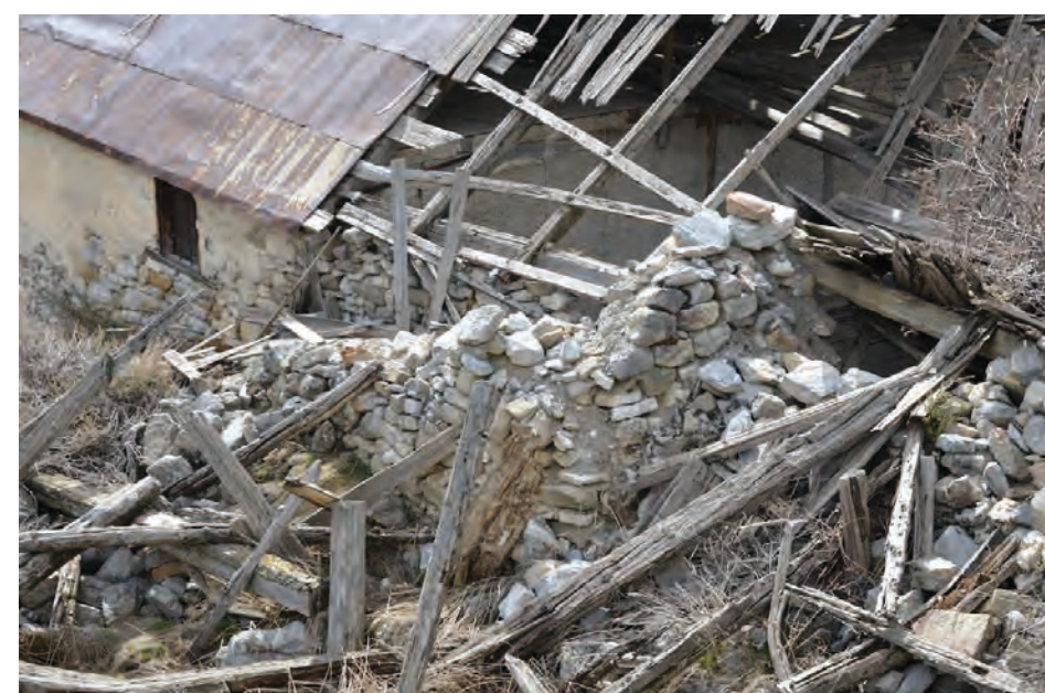
Maçonnerie d'un bâtiment antérieur
