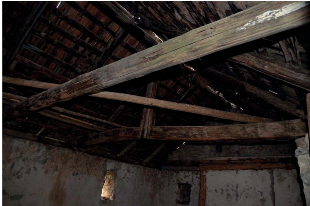
Charpente, partie nord Cliché de V. Labbas, 2012
