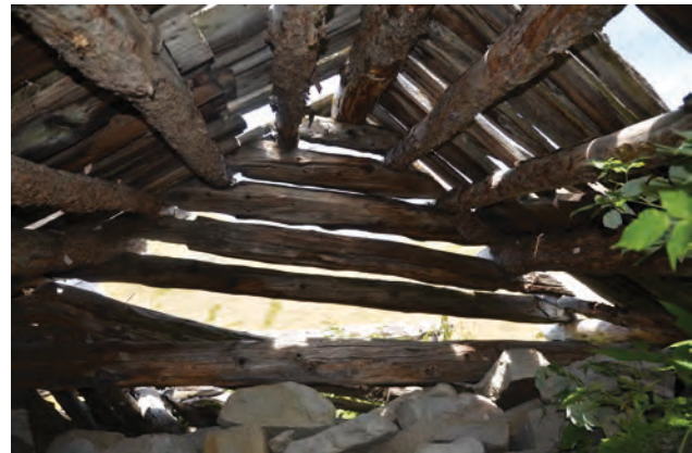
Partie haute du mur pignon nord 408 vue de l'intérieur.
