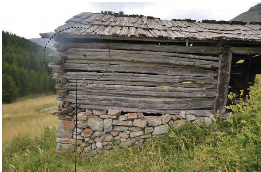
MR 507 vue extérieure de la partie sud.
