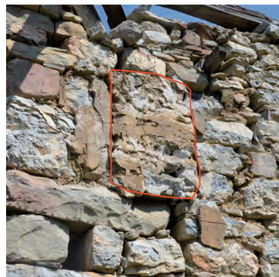
Comblement de la fenetre ouest (US 50206). Cliché de V. Labbas, 2012
