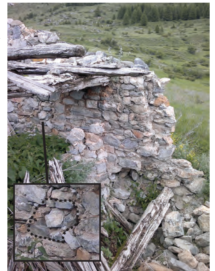
MR 302, parement interne à l'ouest et trou rebouché.
