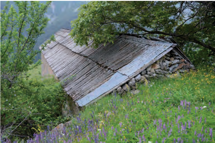
MR 1101 et toiture vue du nord Cliché de V. Labbas, 2012
