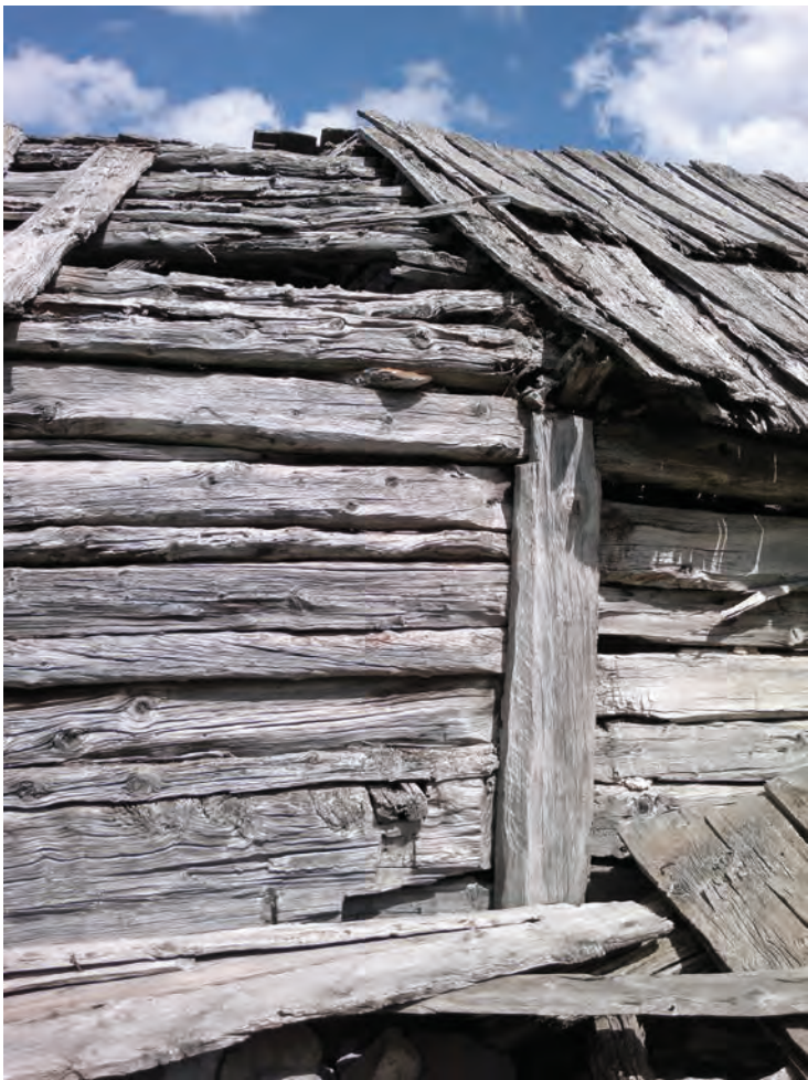
Façade ouest : détail du chambranle au centre de l'élévation à R+1.
