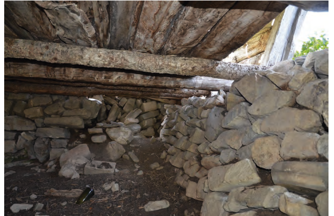
Mur 504 (à droite) : On remarque un fruit qui est très probablement une volonté du constructeur de bâtir un mur selon les techniques des murs de terrasse en pierres sèches.
