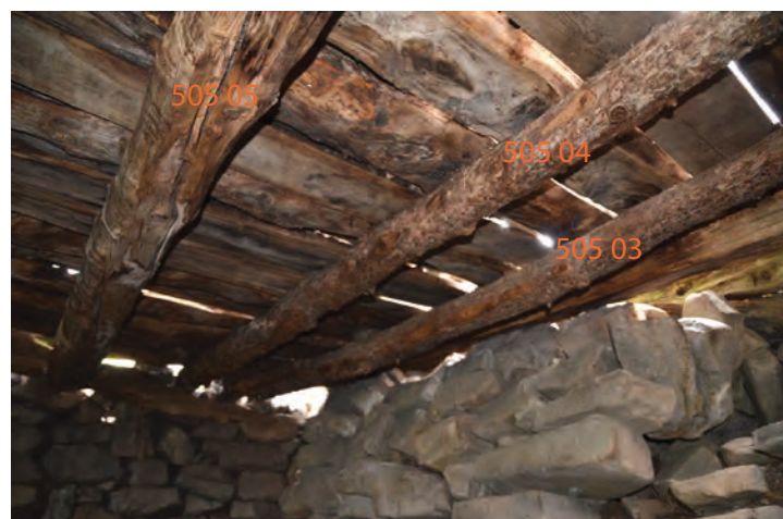
plancher 505. Poutres 50503 et 50504 et 50505.
