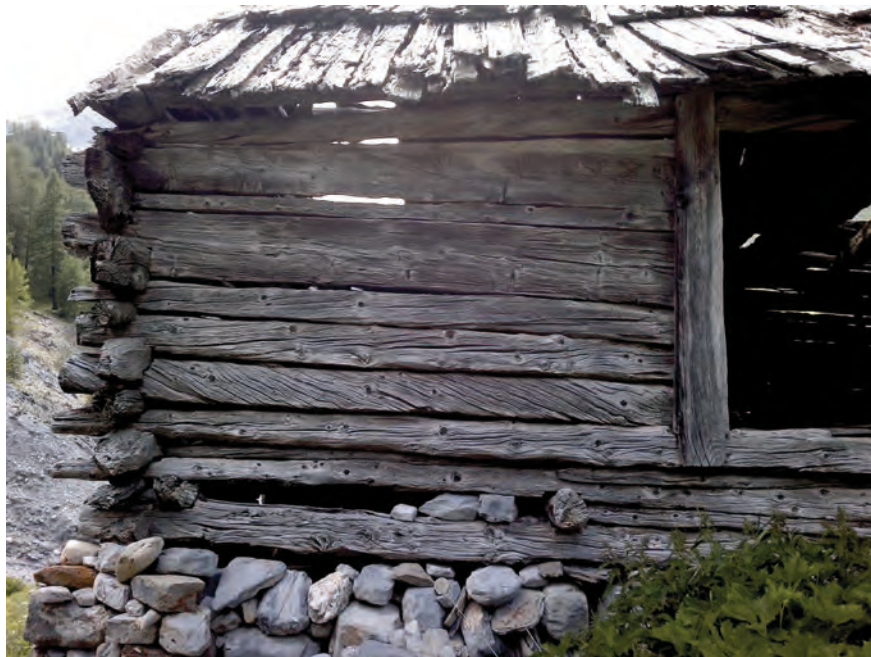
Détail de la partie sud.
