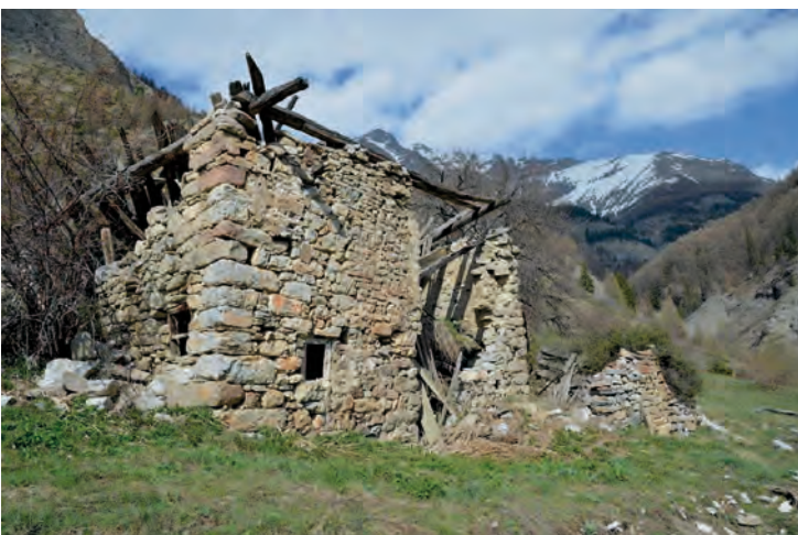
Façade sud (MR502) Cliché de V. Labbas, 2012
