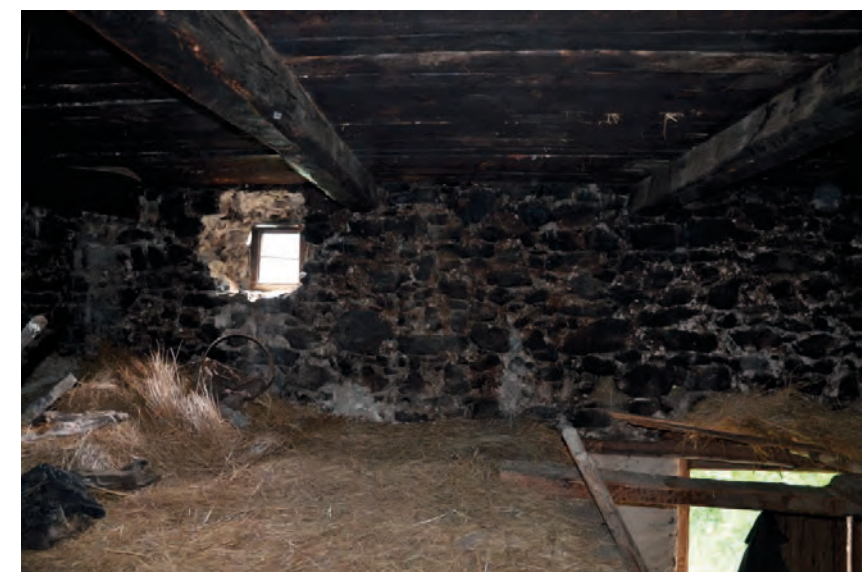
Plancher 1110 et mur 1107. Cliché de V. Labbas, 2012
