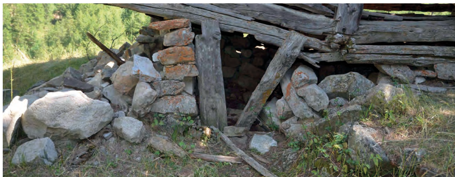
MR 104 vue de l'extérieur Cliché de V. Labbas, 2012
