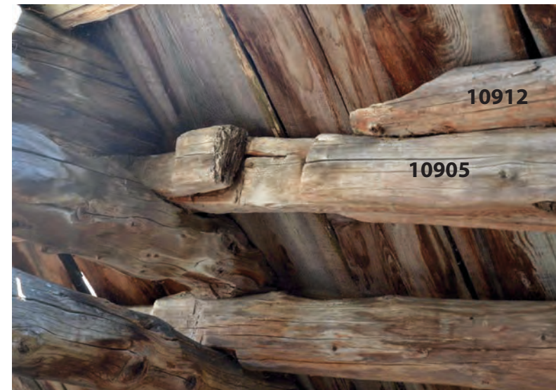
Détail des pannes 10912, 10905 (remplois) Cliché de V. Labbas, 2012
