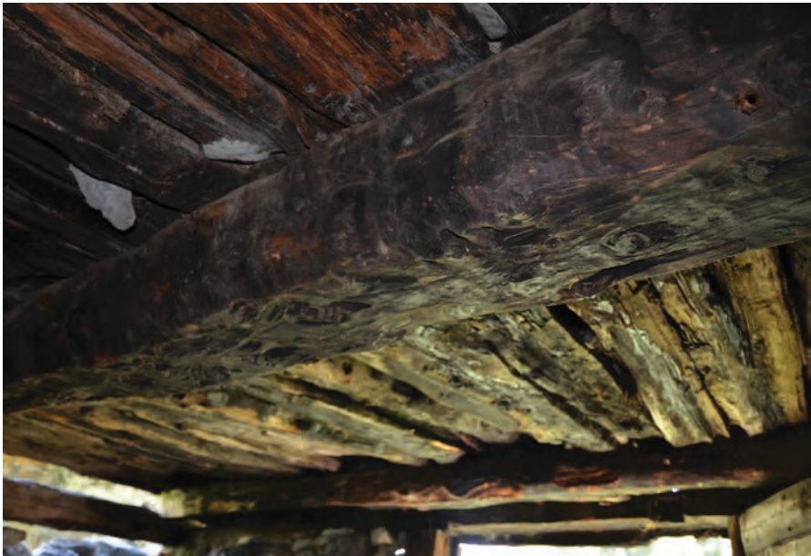
PLancher R0 : détail de la poutre 10501.
