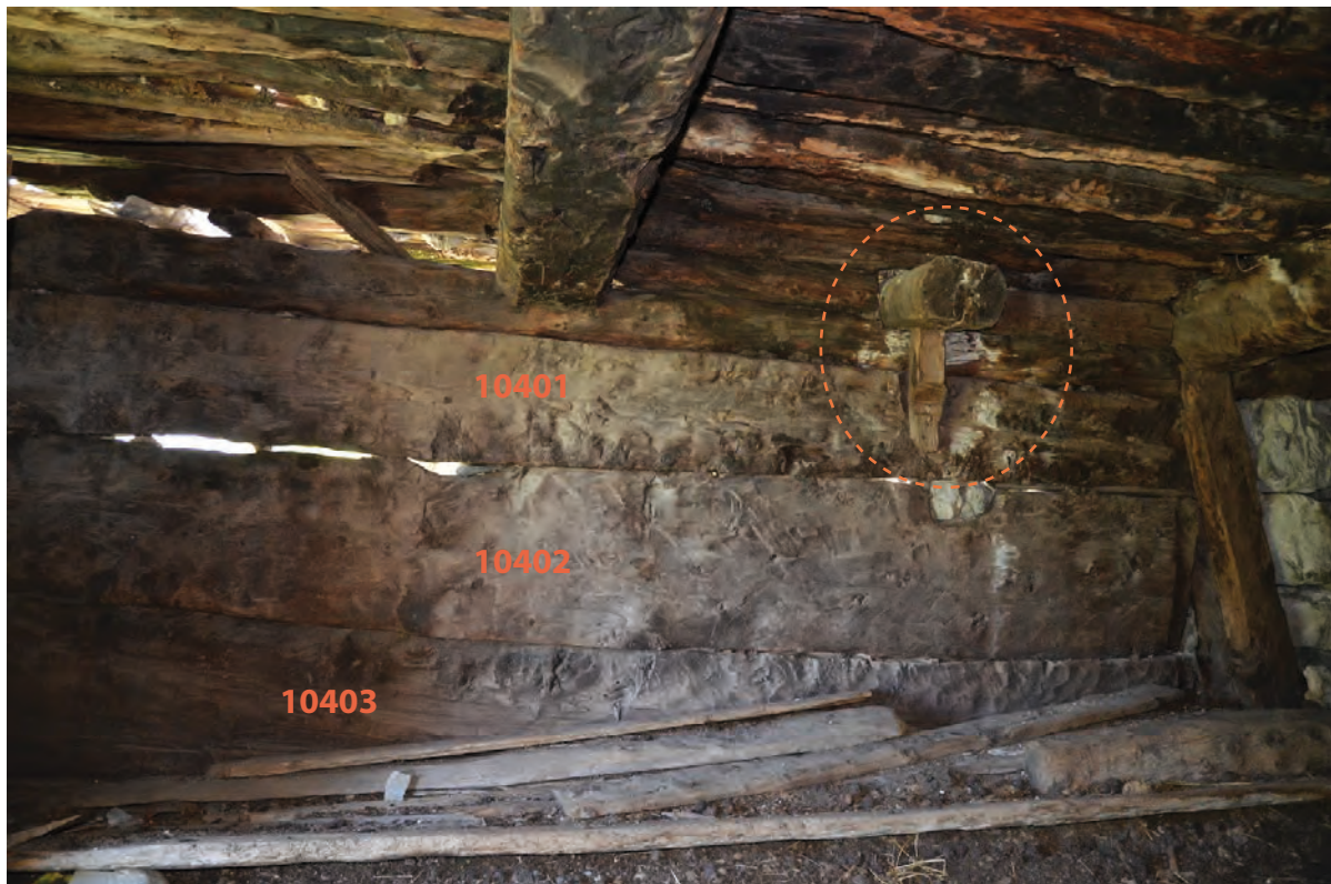
Mur ouest intérieur, partie sud. Dans le cercle en pointillé on peut voir une poutre de l'appentis ancrée dans le mur en bois de la grange.
