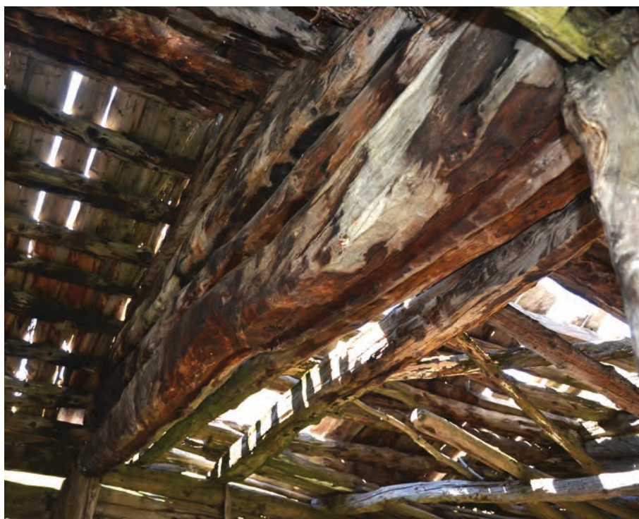
Niveau R+1, refend-formant-pignon vue du nord.
