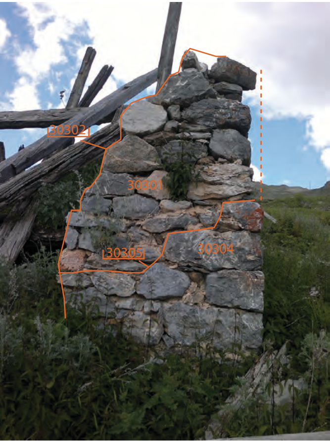
Mur 303: croquis stratigraphique de la maçonnerie nord.
