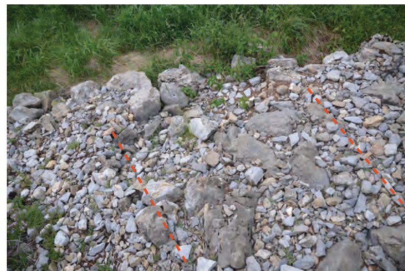
Détail de la voûte d'adduction d'eau de l'ancien moulin.
