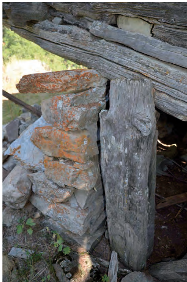
Détail piédroit et maçonnerie extérieur Cliché de V. Labbas, 2012
