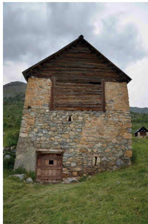
Travertin dans les chainages d'angle Cliché de V. Labbas, 2012
