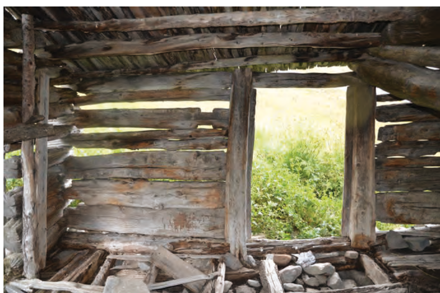
MR 507 vue intérieure de la partie nord.
