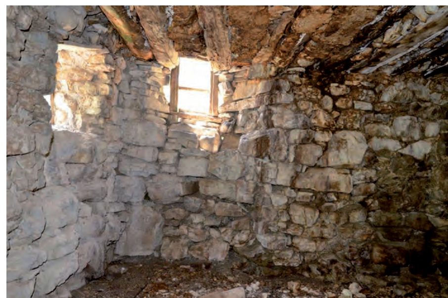
Vue de la partie sud et de la fenêtre. Cliché de V. Labbas, 2012
