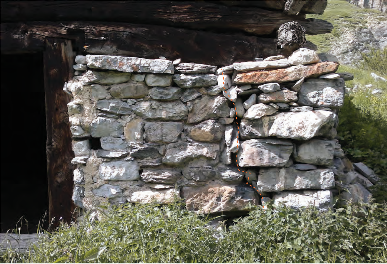
Maçonnerie et pierre sèche à l'est de la porte.
