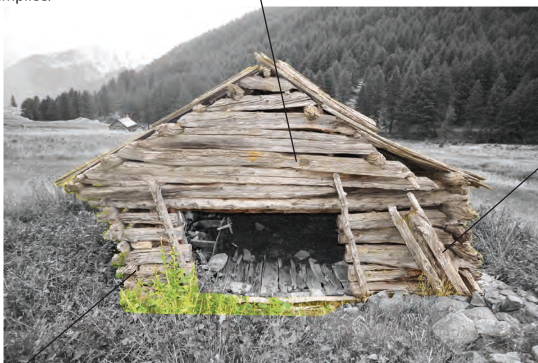
Mur 506, vue générale du nord.
