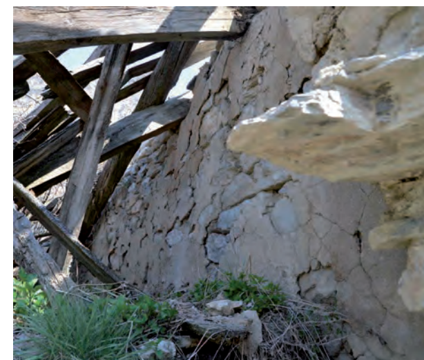
MR501, parement interne enduit, R+1. Cliché de V. Labbas, 2012
