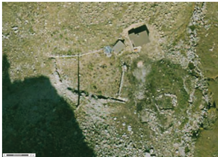
Valplane / Prés de Madame de France, vue aérienne, détail d'une structure pastorale en activité d'après IGN.
