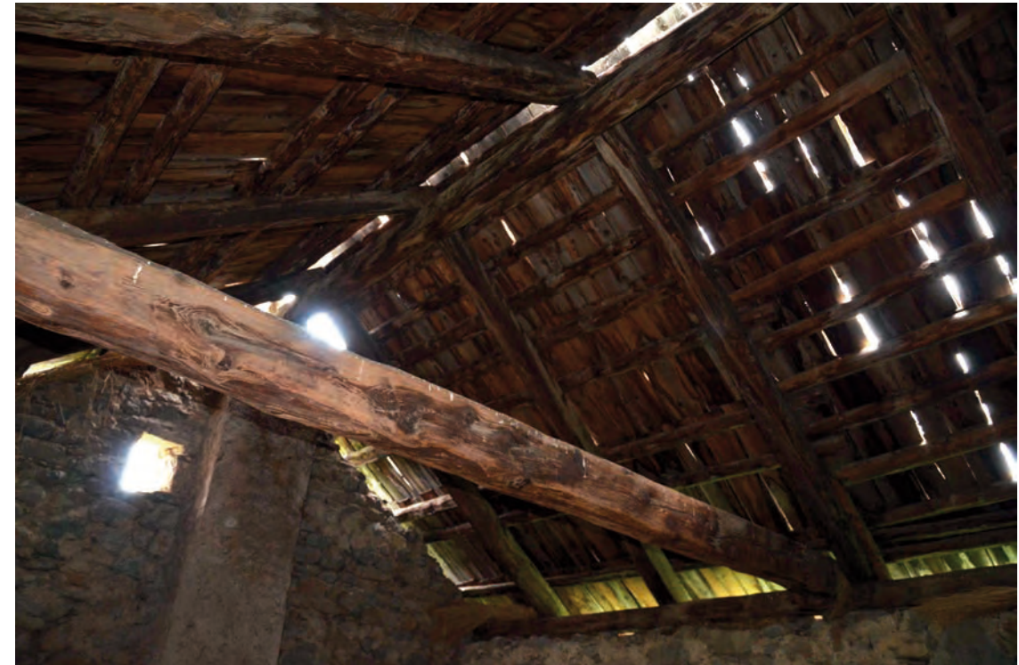
Charpente, partie sud Cliché de V. Labbas, 2012
