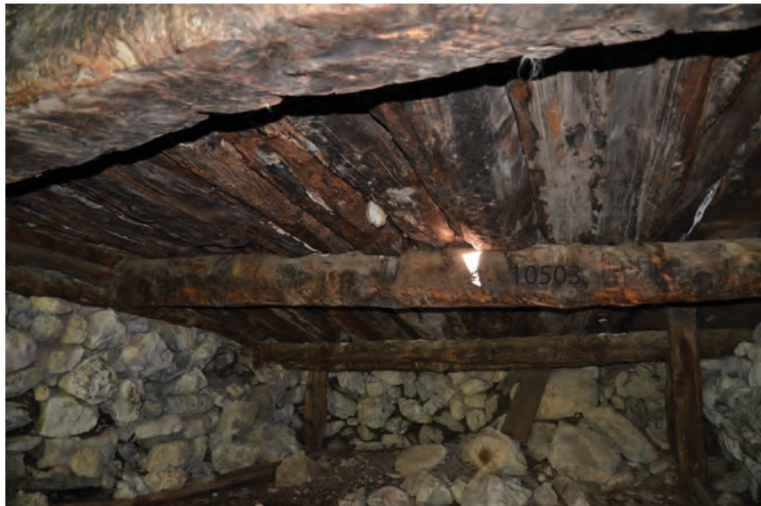
PLancher R0 : vue de la partie nord ouest.
