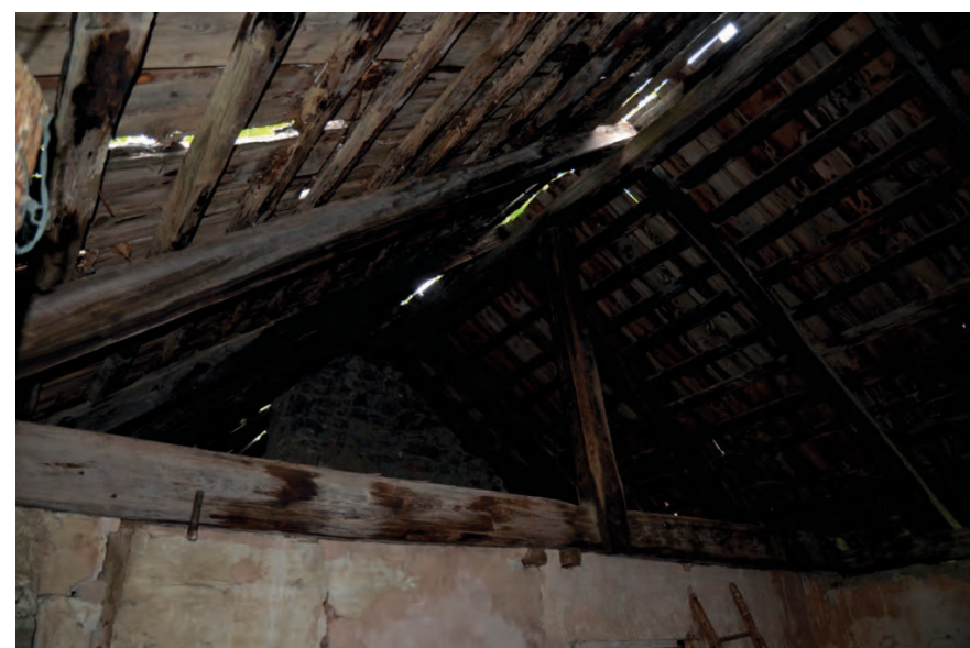
Charpente à R+3, nord Cliché de V. Labbas, 2012
