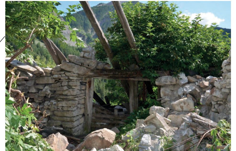
Détail de la porte au sud, Cliché de V. Labbas, 2012
