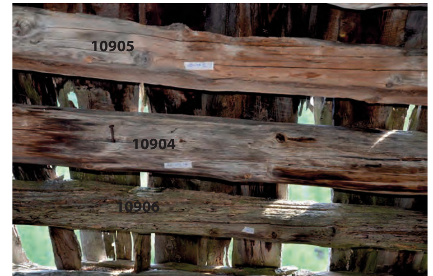
Détail des pannes 10905, 10904, 10906. Cliché de V. Labbas, 2012
