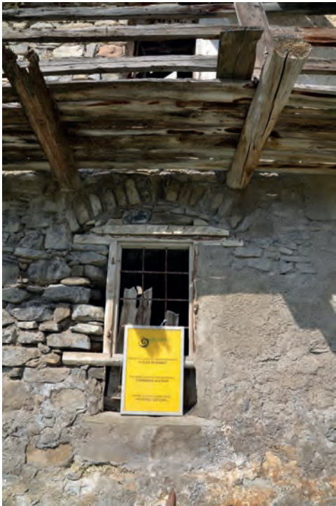
Fenêtre réduite, niveau R0. Cliché V. Labbas, 2012
