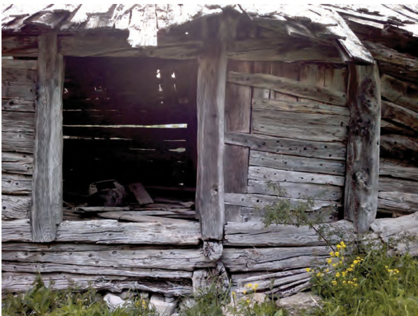
Détail de la porte d'accès et de la porte condamnée.
