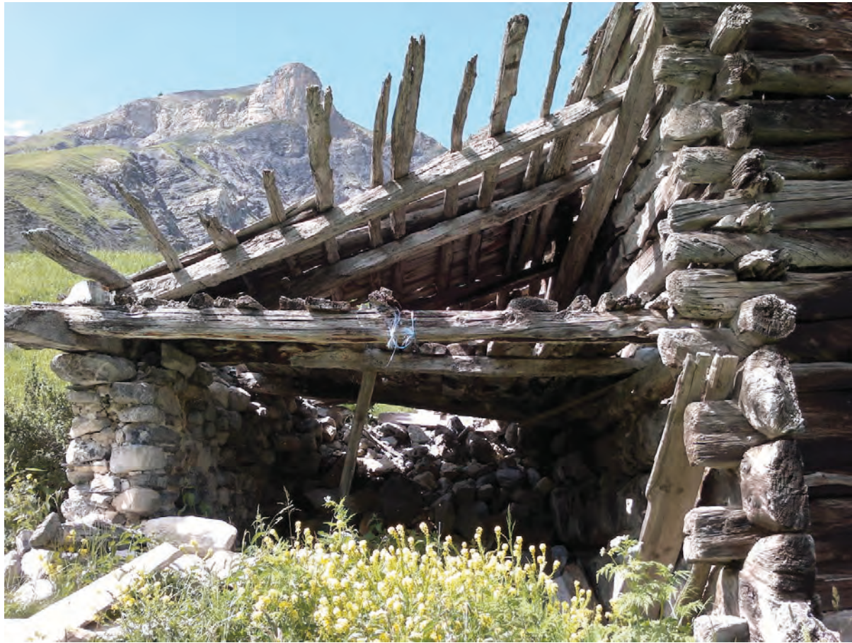
Vue générale du sud
