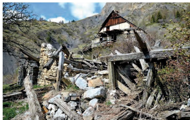
Détail de la façade sud Cliché de V. Labbas, 2012
