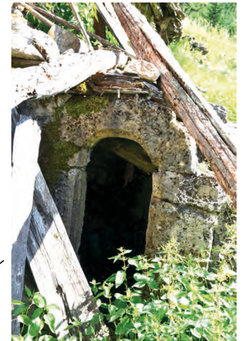
Travertin employée dans une baie (Pra Géla, Beuil) Cliché de V. Labbas, 2012
