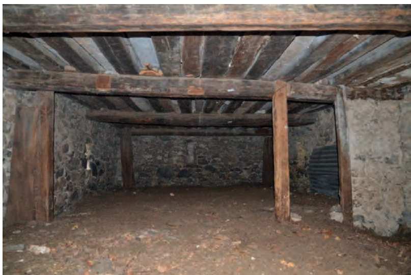
Plancher 1111, vue sud. Cliché de V. Labbas, 2012
