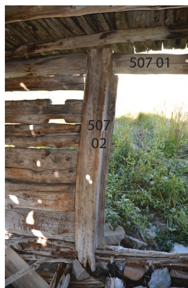
Mur 507, détail du linteau 50701 et du chanbranle 50702 vue de l'intérieur.
