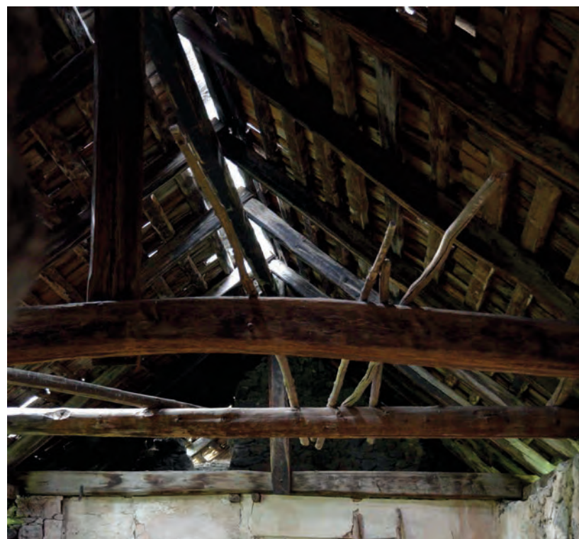
Charpente, partie nord, détail des fermes Cliché de V. Labbas, 2012
