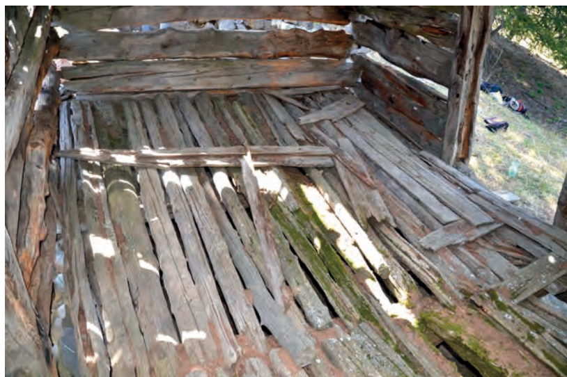
Plancher 115, partie sud. Cliché de V. Labbas, 2012
