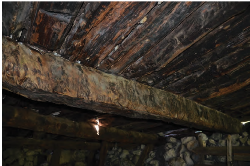
PLancher R0 : vue de la poutre 10502 (vue du sud-ouest).
