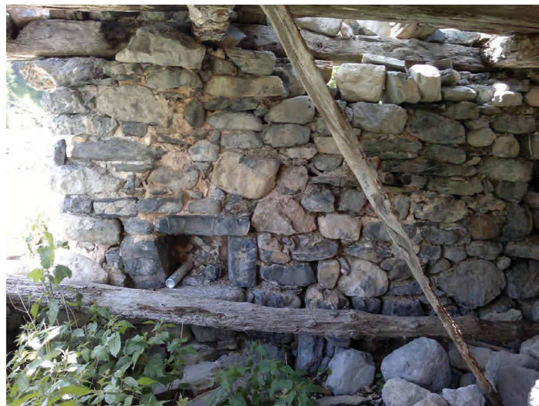
Détail du mur maçonné à l'ouest
