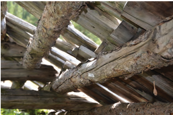
Détail de la toiture 412
