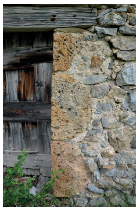
MR 1104, détail piédroit en poudingue (porte R+3 nord.) Cliché de V. Labbas, 2012
