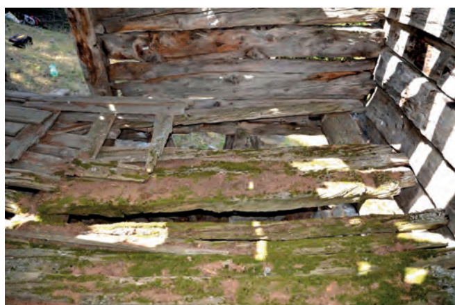
Plancher 115, détail partie nord-ouest. Cliché de V. Labbas, 2012
