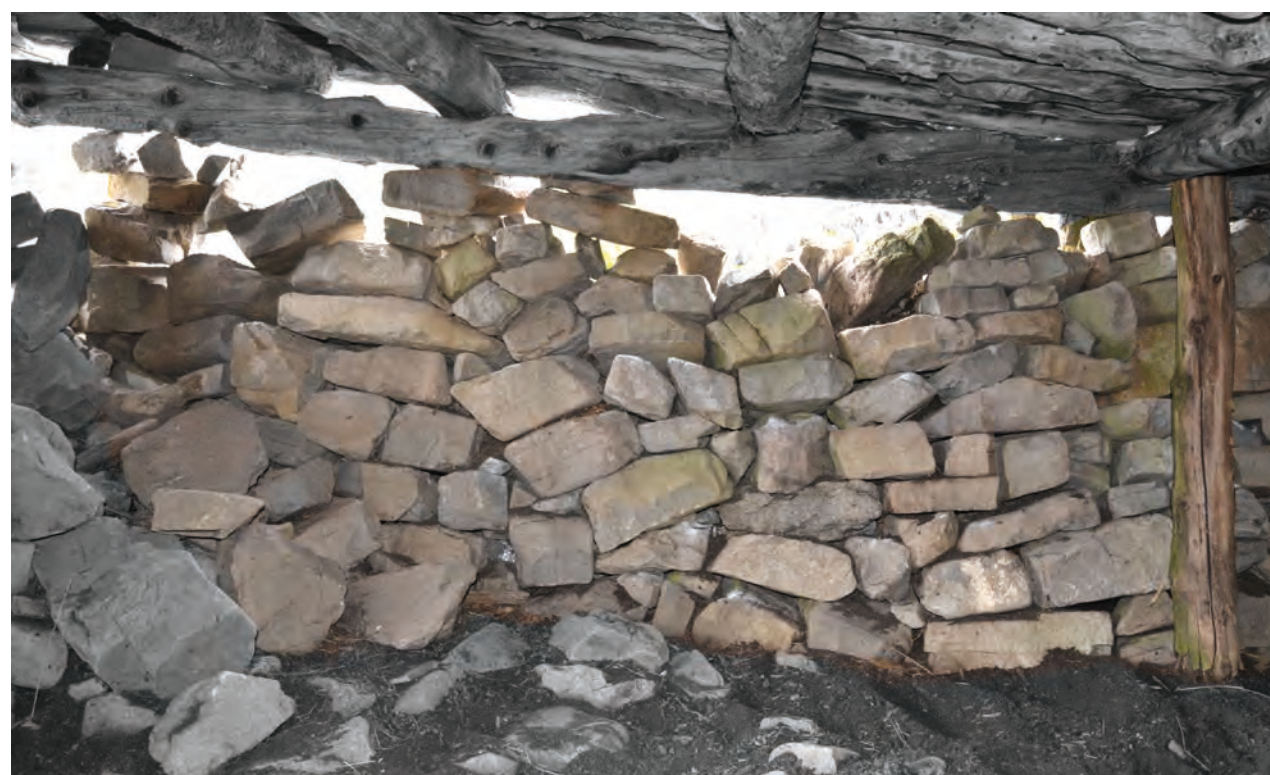
MR 502 vue du parement intérieur, partie sud.
