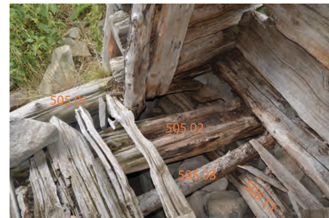
Plancher 505: Poutre /sablière 505 01, poutres 505 02 et 505 03 et sablière 505 15.
