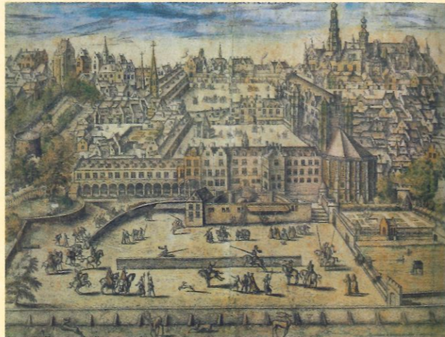
1. Le palais de Bruxelles, gravure à l'eau-forte et au burin, mise en couleurs, XVI e siècle, Bibliothèque royale de Belgique, Cabinet des Estampes, Bruxelles. Ce palais se trouvait non loin de l'actuel Palais Royal, dans l'angle droit de la Place Royale, quand on regarde vers la ville (l'endroit, qui a fait l'objet de fouilles, peut être visité). Il fut détruit par un incendie en février 1731, sous le régime autrichien.
