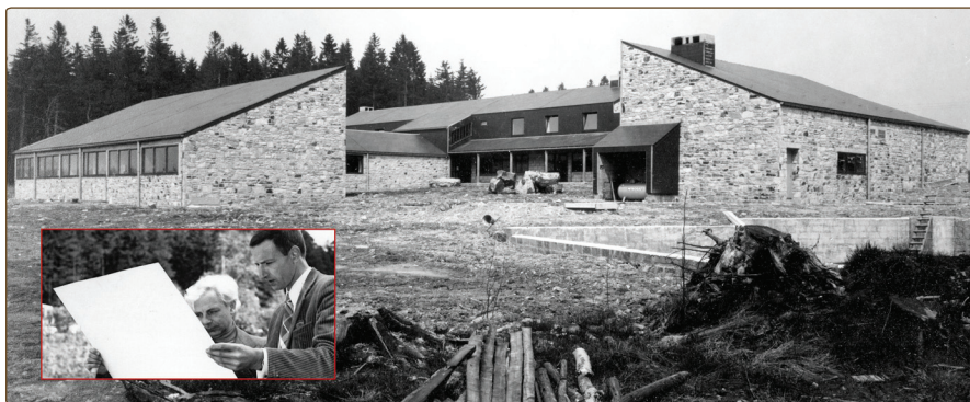
Fin des travaux de la troisième station. En médaillon, Jean Englebert et René Schumacker.
