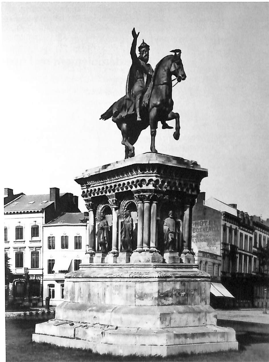
Fig. 3.- Statue équestre de Charlemagne en 1887 : la dégradation de la pierre de Caen et les deux lignes de l'inscription sont bien visibles.
