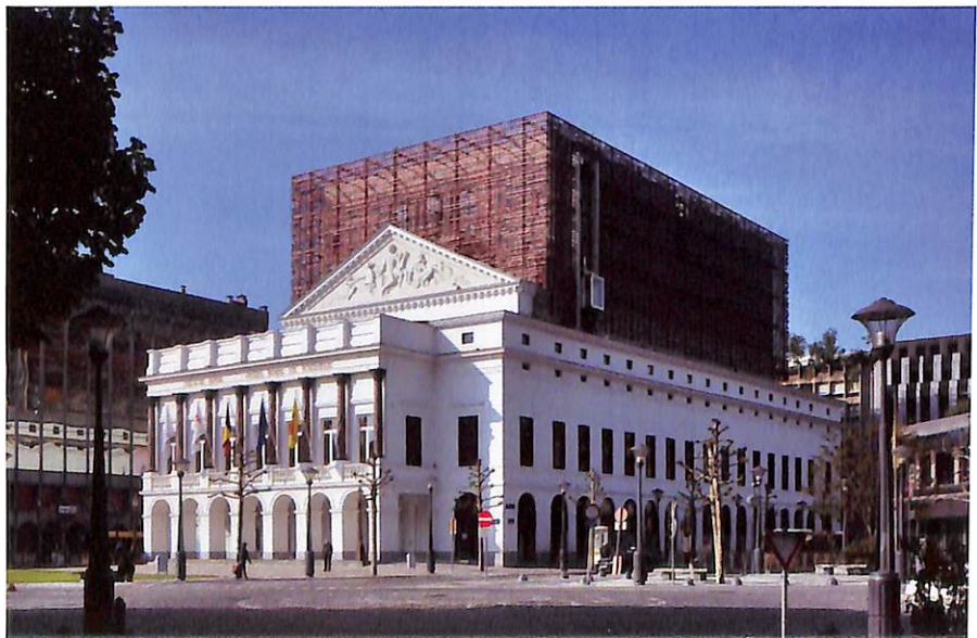
Fig. 3.- Théâtre royal rénové : duo hardi ! Bureaux d'études A2RC, Origin, Architectes Associés S.A., Techniques Générales et Infrastructures S.A. © Georges De Kinder.
