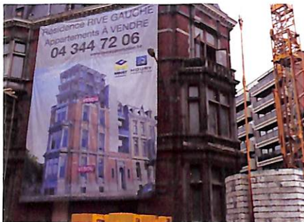
Fig. 8.- Cacophonie promise au coin de la rue Forgeur et du boulevard Frère-Orban. L'important, c'est la vente ! chantent à l'unisson les promoteurs immobiliers.
