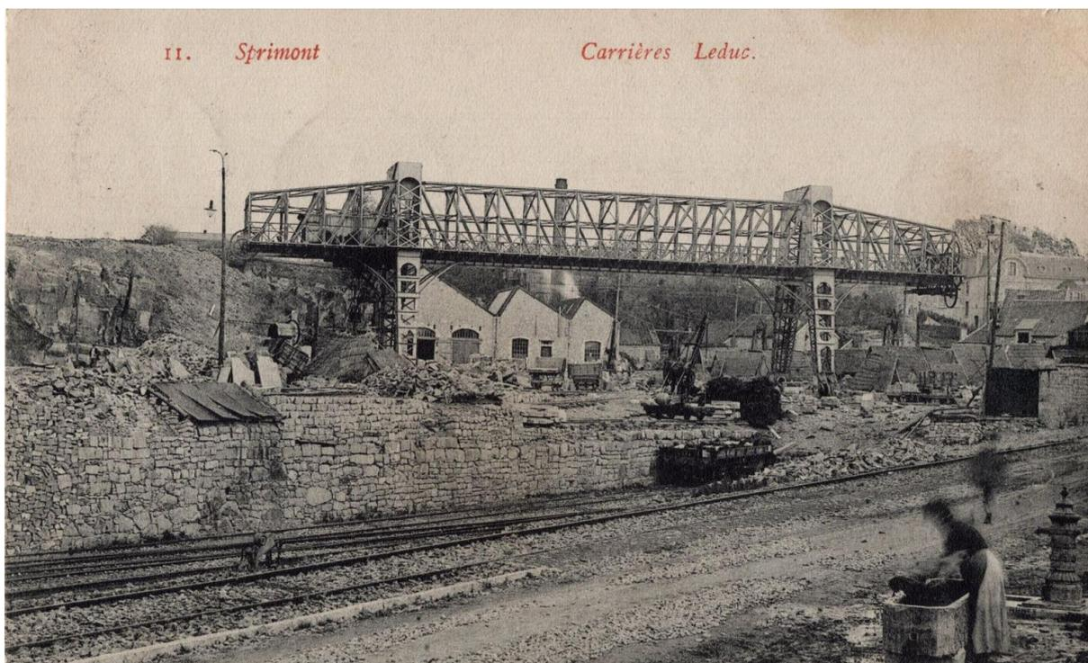
*Photographie du début du XX<sup>e</sup> siècle sur laquelle apparaissent le chemin de fer vicinal, le raccordement de la carrière, une grue locomobile, le pont-roulant et la scierie Leduc-Dufays. Collection Antoine Baudry.*
