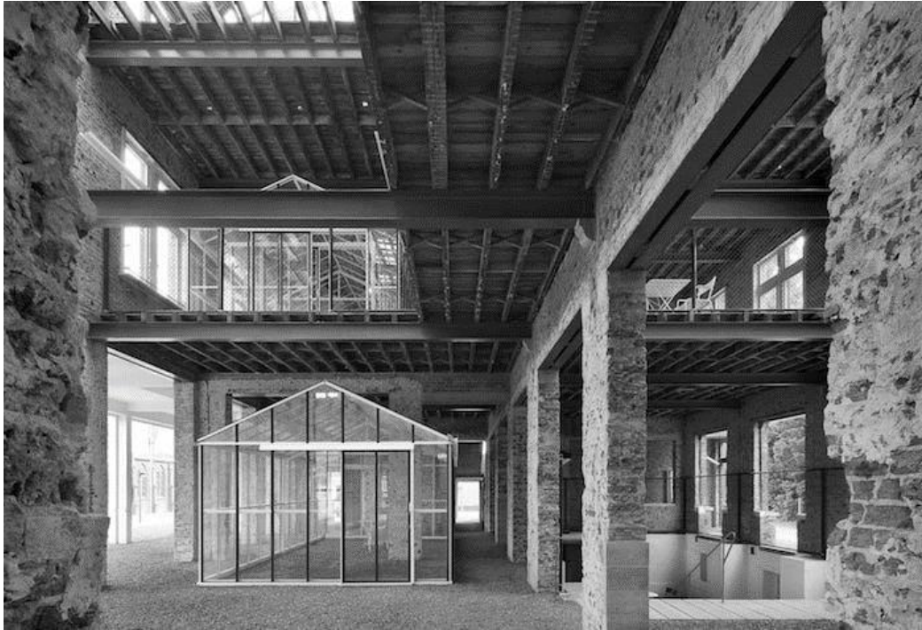
Reconversion du bâtiment Sint Jozef – Campus Caritas – Arch.: De Vylder Vinck Taillieu © Filip Dujardin
