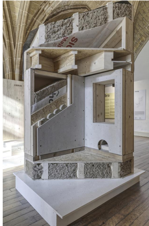
Mobic : ossature bois, isolant en herbe, renfort d'inertie en terre
