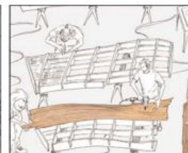
LES BRINS DE ROTIN SONT ALIGNÉS ET CLOUÉS CÔTE À CÔTE SUR CETTE STRUCTURE.
