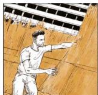
PAR RANGÉES SUCCESSIVES, LES BOTTES SONT POSÉES SUR LE TOIT. LES TIGES DE ROSEAU SONT ÉTALÉES, FAÇONNÉES ET SERRÉES SOUS DES BARRES HORIZONTALES EN ACIER GALVANISÉ.
