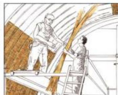
LES MONTANTS VERTICAUX, FAITS DE BRINS D'OSIER ÉCORCÉ, SUIVENT LES ARCS EXISTANTS EN BÉTON ARMÉ.
