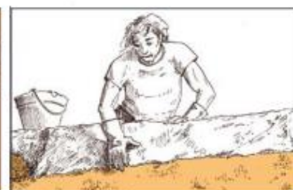
LE FAÏTAGE EST RÉALISÉ À LA CHAUX.
