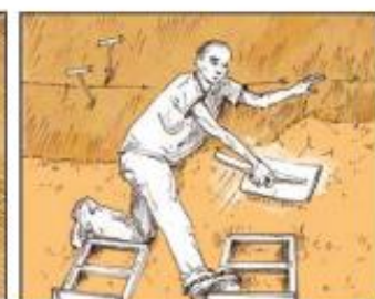
LE CHAUME EST ÉGALISÉ AVEC UN BATTOR.
