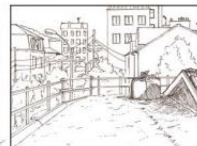
DE LA TERRE VÉGÉTALE EST RÉPARTIE SUR LA TOITURE AFIN DE METTRE LA PAILLE PORTEUSE EN COMPRESSION.
