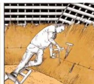
CHAQUE BARRE HORIZONTALE EST FIXÉE À LA TOITURE PAR UN FIL EN ACIER INOXYDABLE PASSÉ SOUS LES LITEAUX GRÂCE AUX AIGUILLES.
