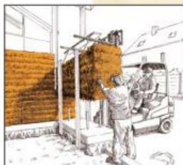
LES BOTTES DE PAILLE SONT CALEPINÉES SANS MORTIER ET LIÉES ENTRE ELLES PAR DES TIGES EN CHÊNE PLANTÉES DIRECTEMENT DANS LES BOTTES.
