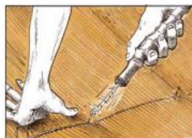
LES TIGES DE ROSEAU SONT SERRÉES ENTRE LA BARRE ET LES LITEAUX À L'AIDE D'UN VRIILLEUR.
