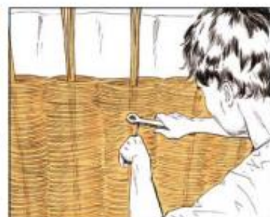
LES BRINS D'OSIER SONT TISSÉS SUR LES MONTANTS EN SUIVANT LE GABARIT DE LA VÔTE.
