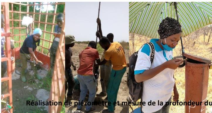
Réalisation de piézomètre et mesure de la profondeur du niveau d'eau
