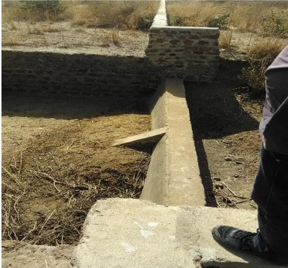
Photo 1 : Seuil N°2 avec dépôt de sédiments
