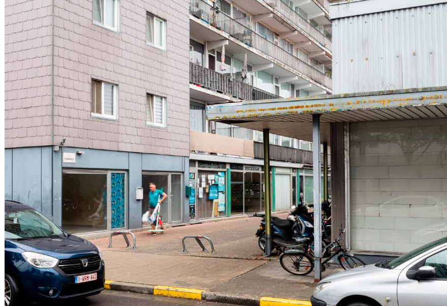
De hoge kostprijs voor het renoveren van het gebouw is een grote uitdaging, die niet zomaar opgelost kan worden.
