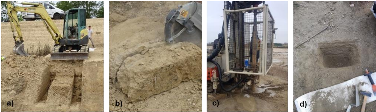
Figure 3. Pelle mécanique pour creuser les tranchées (a), sciage d'un bloc après extraction (b), carotteuse triple tube (c) et point d'échantillonnage manuel (d).
