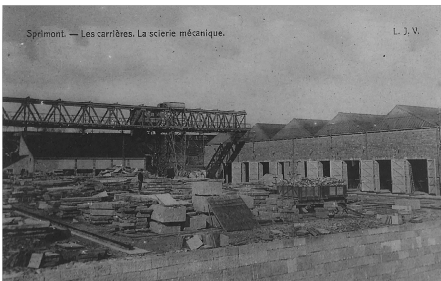
Fig. 1 : la modernité dans la carrière de Correux à Sprimont au début du XX e siècle : pont-roulant desservant le parc à tranches, scierie électrique (à droite) et forge (à gauche). Collection du Centre d'Interprétation de la Pierre de Sprimont.
