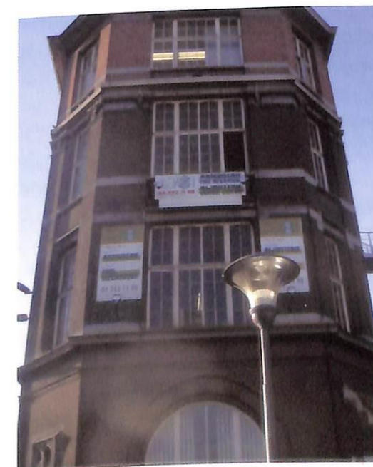
À gauche, la plus dérangeante des publicités sur la façade principale.
