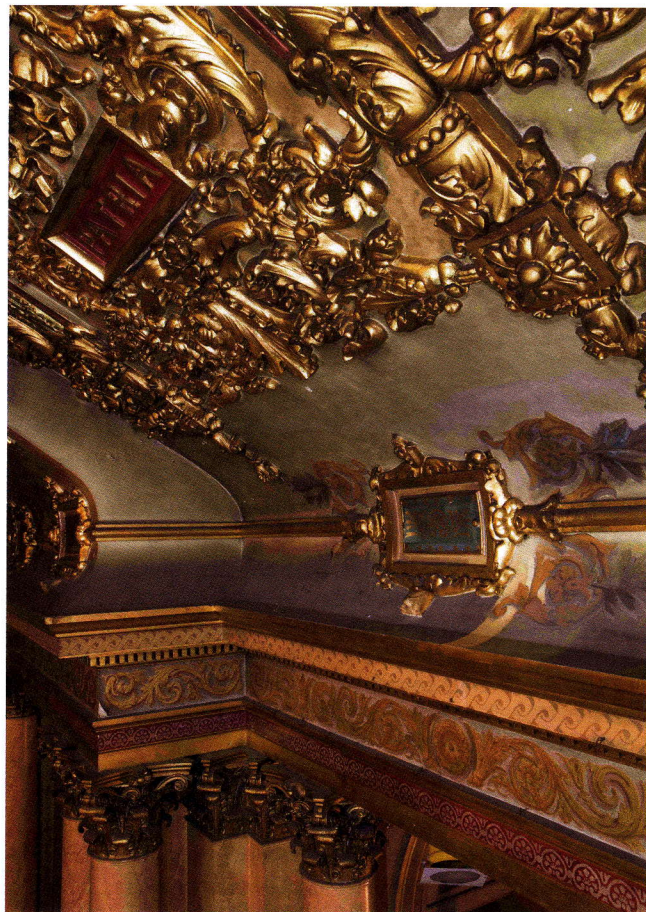
Vue d'une travée depuis l'échafaudage (© IRPA-KIK Bruxelles)
