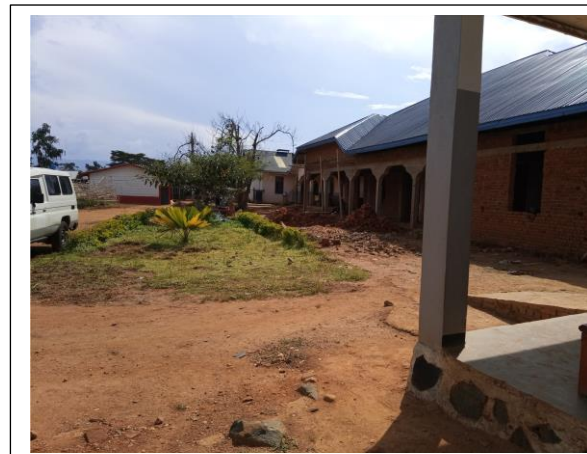
Notre photo, 02/11/2020 : Chantier en construction grâce à la gratuité des soins
