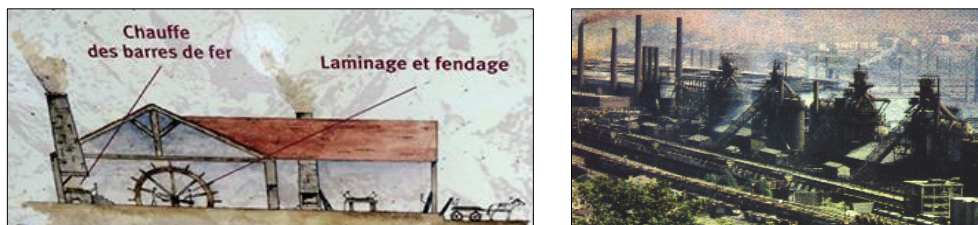
Figure 12 : à gauche, une forge métallurgique artisanale régie par la force hydraulique et l'usage d'un four à bois. A droite, une usine sidérurgique régie par la force vapeur et l'usage de fours à coke (Chryzode, 2009 ; Persin, 2018)
