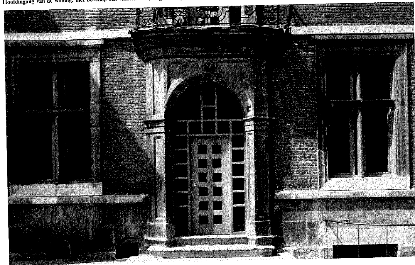
Porte principale du logis, surmontée à l'étage d'une porte-fenêtre donnant sur un balcon orné d'un garde-corps en fer forgé (aménagement du XVIII e siècle). Hoofdingang van de woning, met bovenop een vensterraam, uitgevend op een balkon met een smeedijzeren leuning (verbouwing uit de 18e eeuw).
