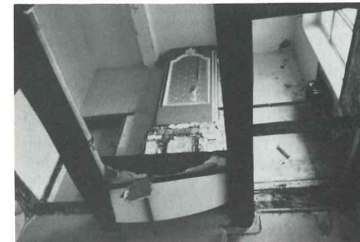
Fig. 3. — Une des pièces de l'étage vue du rez-de-chaussée. D'après une diapositive prise en février 1994.
