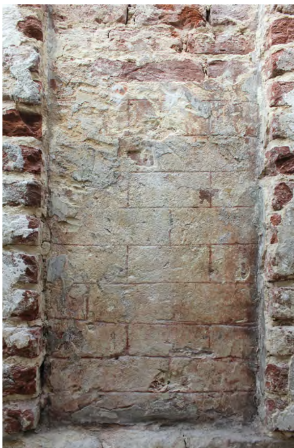
Fig. 3 Vestiges de l'enduit en faux appareil en briques (photo A. Baudry © urban.brussels-ULiège).
