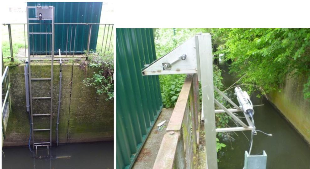
**Fig. 6-83. Échelle supportant la sonde et équipée d'un treuil manuel permettant de remonter la sonde au niveau de la berge pour en faciliter la maintenance.**
