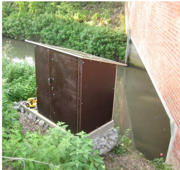
**Fig. 6-26. Installation de la cabine à équipement de la Petite Gette sur la dalle en béton.**
