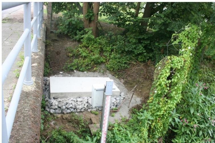
Fig. 6-9. Installation de la dalle en béton sur le site choisi à Florival.
