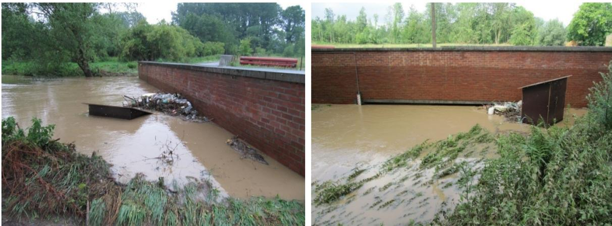
Fig. 6-33. Accumulation de corps flottants en amont du pont le 29/06/2011 au matin durant la décrue de l'événement extrême ( $T_a \gg 200$  ans).
