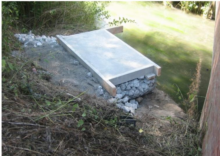
Fig. 6-17. Installation de la dalle en béton sur le site choisi à Opheylissem.
