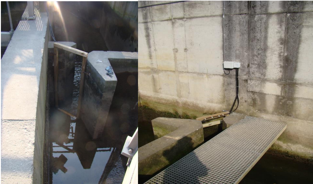
Fig. 5 : Photo de l'antenne de détection RFID placée au niveau de la dernière échancrure de la passe à poissons de Monsin (à gauche) et celle installée en 2015 dans la partie aval de l'échelle à poissons (à droite).
