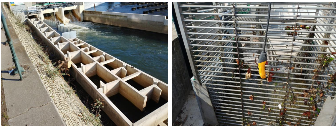
Fig.10 : Vue aval de la nouvelle passe à poissons installées en rive droite (à gauche) et photo de la cage de capture installée dans le bassin le plus en amont (à droite).
