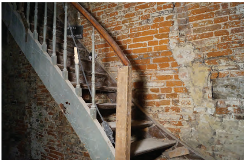
Fig. 2 : Rue du Marché-aux-Herbes, 36 : vestiges d'un habitat antérieur au bombardement datée entre le xiv e et le xvi e siècle.
