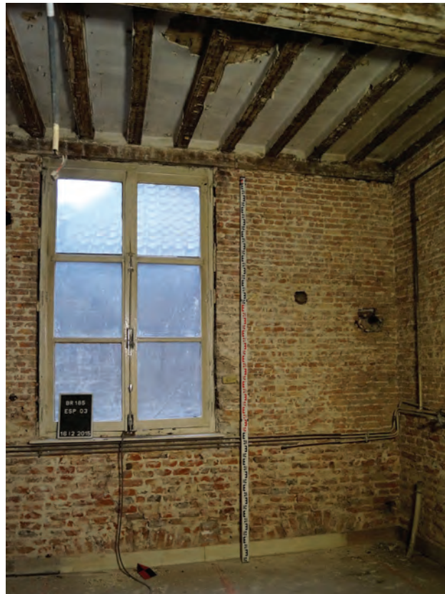
Fig. 3 : Rue Marché-aux-Herbes 8-10 : façade arrière, maçonnerie construite en brique de remploi et briques d'importation.
