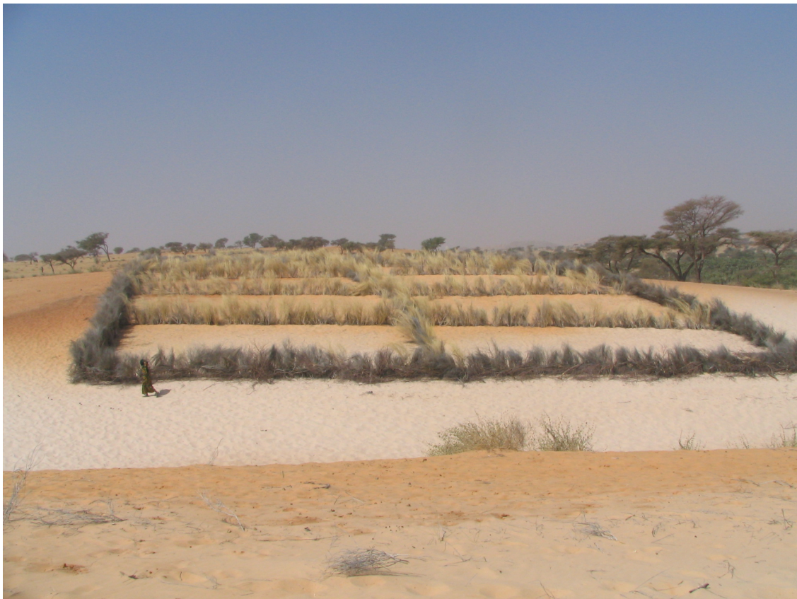
Photo 2: Vue du clayonnage installé sur la dune de Woro en juin 2005 ( Source : Laminou, janvier 2006)
