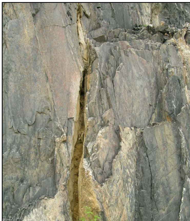
Figure 2.24. Fente dans les grès sur le site de construction du barrage, rive droite de la rivière Bo
