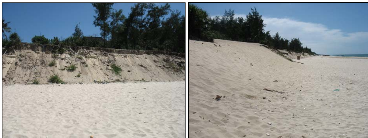
Figure 3.31. L'érosion au village de Tan Loc, commune de Quang Cong
