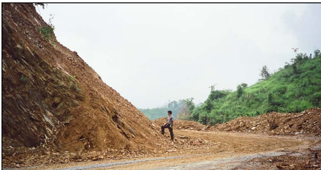
Figure 4.23. Glissement de terrain sur un plan de stratification
