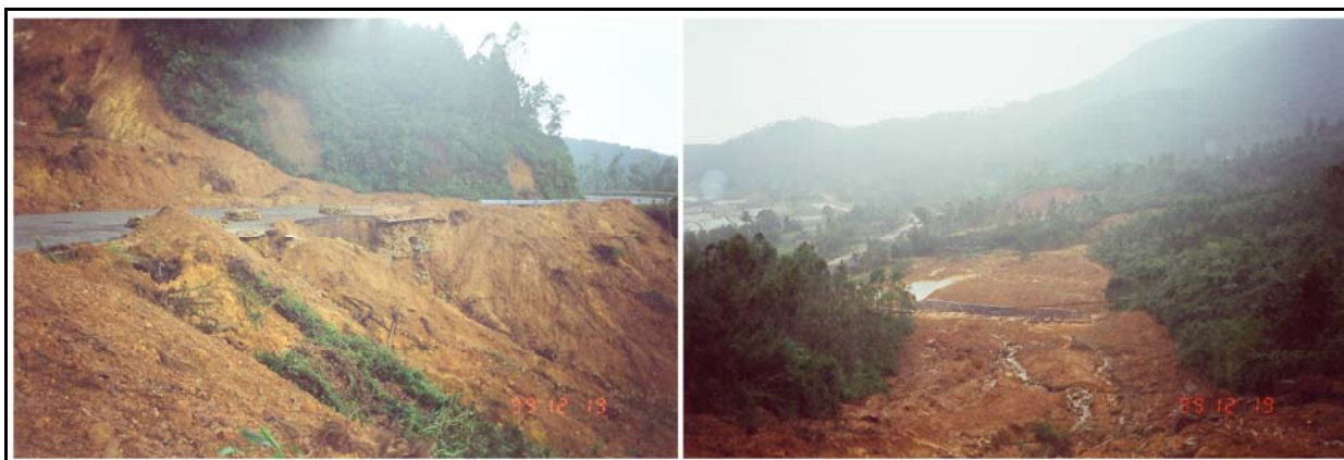
Figure 4.5. Glissement au col de Phuoc Tuong détruisant la route (gauche) et bouchant le tunnel de chemin de fer (droite)
