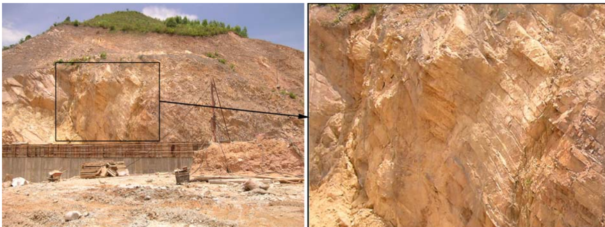
Figure 2.23. Fente dans les grès sur le site de construction du barrage, rive gauche de la rivière Bo
