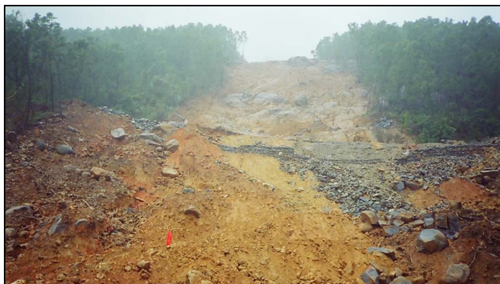
Figure 4.4. Glissement de terrain sur la route nationale N°1 au col de Hai Van
