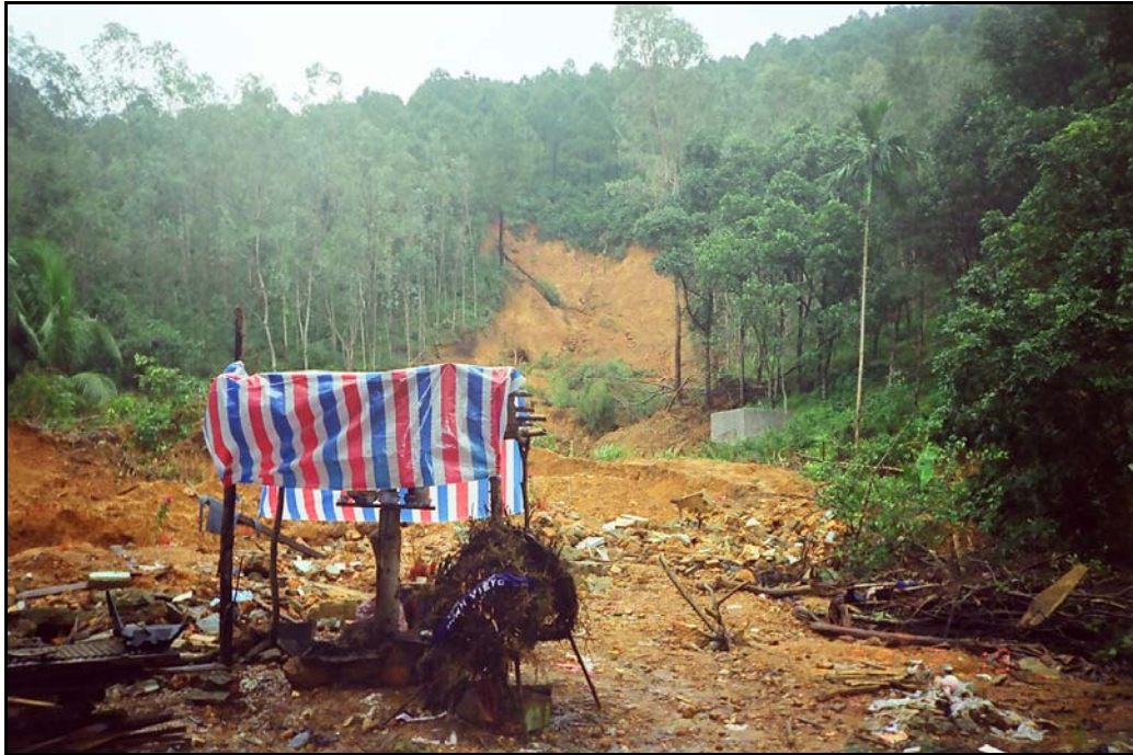
Figure 4.6. Glissement de terrain qui a causé 13 morts, 1 blessé à Da Bac 1, Phu Loc
