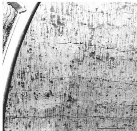
Figure 2-26 : Fractures de dessiccation dans la zone endommagée d'une cavité construite dans l'argile de Tournemire (roche envisagée pour l'enfouissement de déchets radioactifs) (d'après IRSN)
