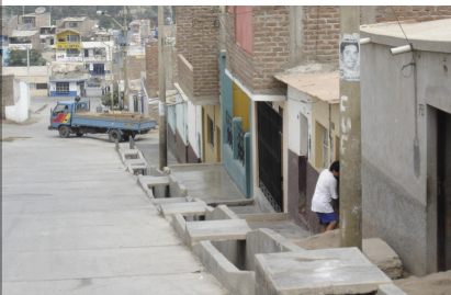
Los desagües en la mayor parte de la ciudad son abiertos, sobre todo en las zonas de mayor pendiente
