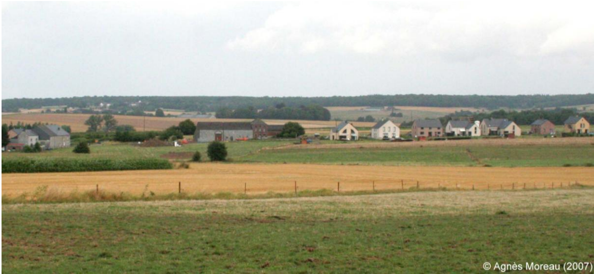
Extension du bâti sur le village de Rognée. Les nouvelles maisons, de par leur implantation, leur architecture et leurs matériaux, contrastent avec les caractéristiques urbanistiques traditionnelles du village.
