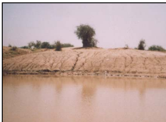
Photo 9.5. L'érosion en griffes (Cliché : Niang, 2006)
