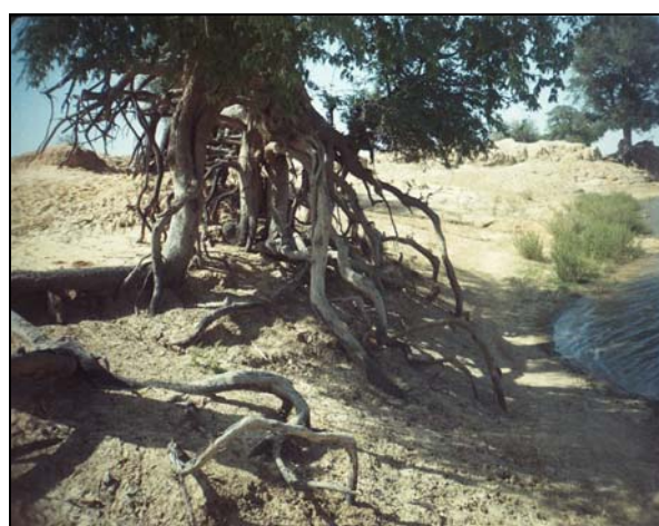
Photo 9.2. Déchaussement d'arbre suite à l'érosion des berges. (Cliché : Niang, 2004)
