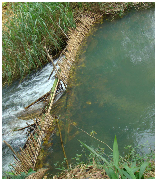
Fig.1.17b. Barrage pour pose de nasse
